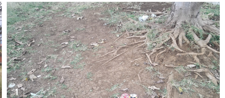
Raíces sobresalientes Foto 82: Fuente propia
