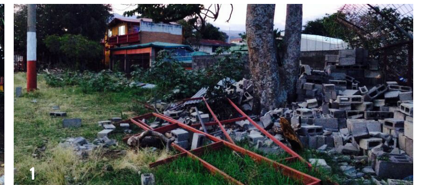
Materiales abandonados en la cancha Foto 66: Fuente propia
