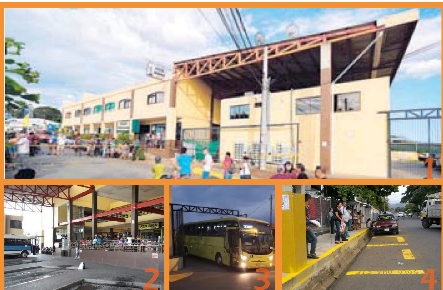
Ilustración 4: Terminal HRC Orotina.
