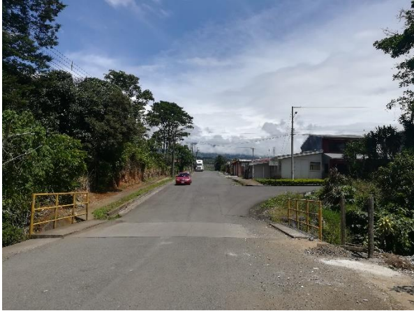
Figura 98. Puente sobre Quebrada Pollo en Paraiso
