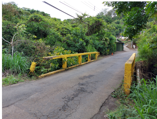
(a) Vista panorámica del puente.
