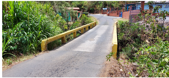
(a) Vista panorámica del puente.
