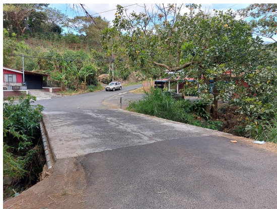
(a) Vista panorámica del puente.
