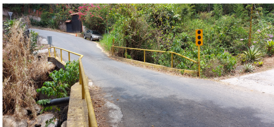
(a) Vista panorámica del puente.
