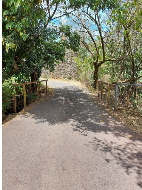
(a) Vista panorámica del puente.
