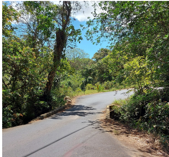
(a) Vista panorámica del puente.
