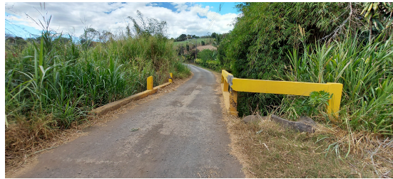
(a) Vista panorámica del puente.
