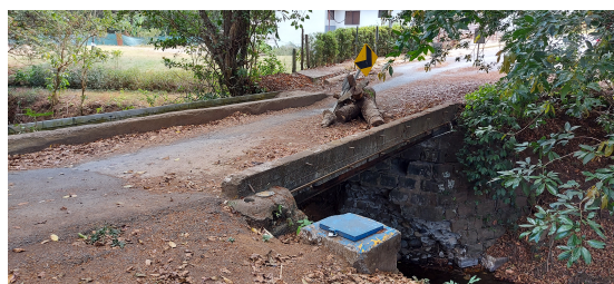
(a) Vista panorámica del puente.
