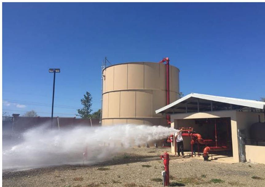
Figura 27. Tanque de almacenamiento de agua. Salvavidas de Centroamérica (2023)
