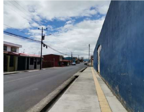
Figura 70: Fotografía 1 del estado de la Calle 5. Fuente: Elaboración propia. Sabrina Izabá Aguilar.
