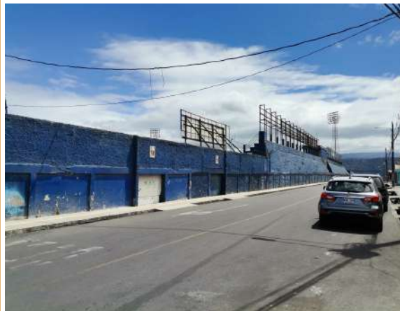
Figura 69: Fotografía 2 del estado de la Calle 03. Fuente: Elaboración propia. Sabrina Izabá Aguilar.
