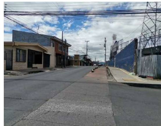
Figura 71: Fotografía 2 del estado de la Calle 5. Fuente: Elaboración propia. Sabrina Izabá Aguilar.
