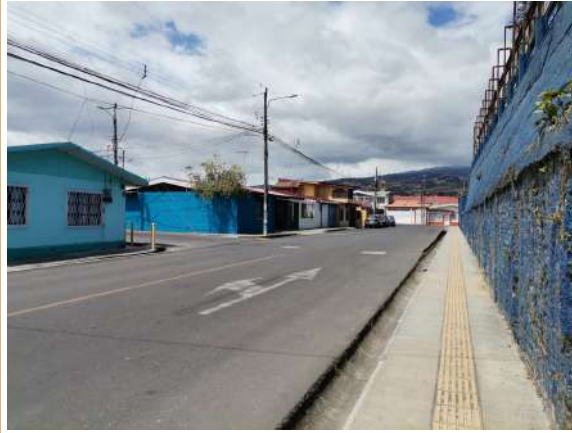
Figura 68: Fotografía 1 del estado de la Calle 03. Fuente: Elaboración propia. Sabrina Izabá Aguilar.
