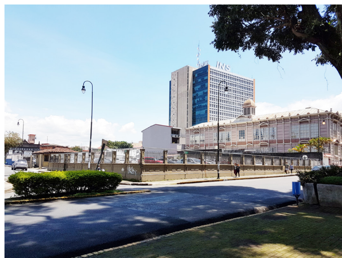
Parqueo Morazán | 7 Calle 7, Avenida 5 y 7
