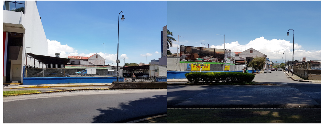
Levantamiento fotográfico: costados surestes. Fuente: Propia
