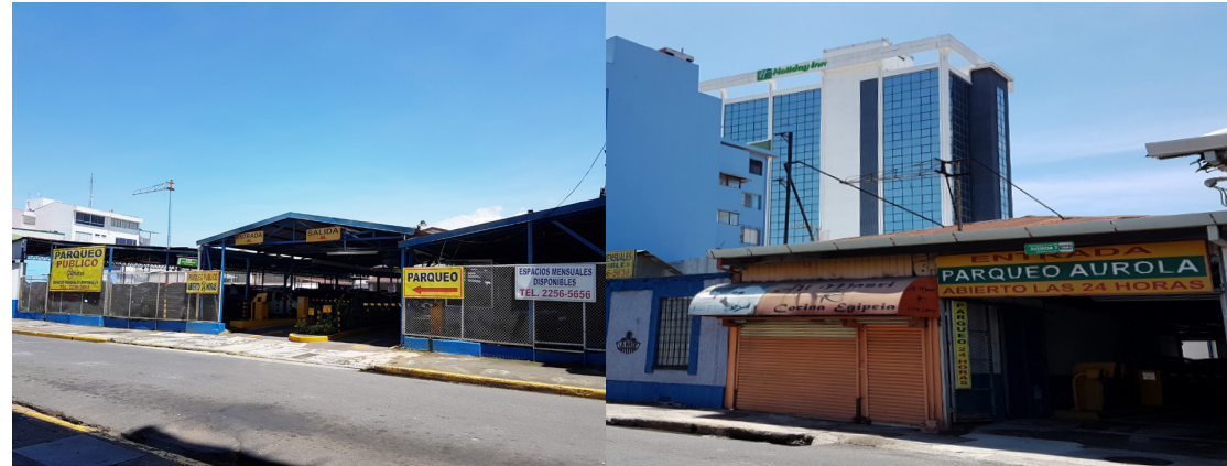
Levantamiento fotográfico: costado sur y costado norte. Fuente: Propia
