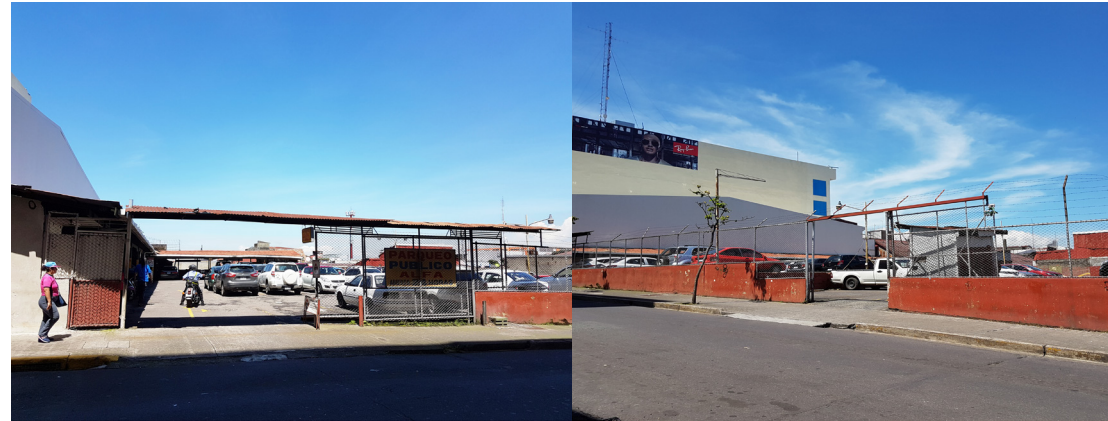
Levantamiento fotográfico: costado este y costado noreste. Fuente: Propia
