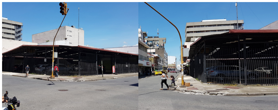
Levantamiento fotográfico: costado sureste y sur, posible paseo peatonal. Fuente: Propia
