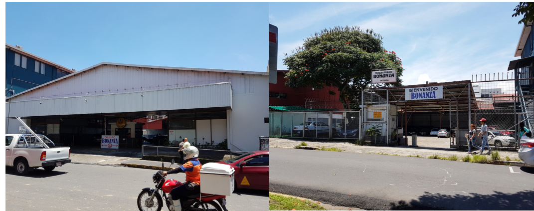
Levantamiento fotográfico: costado sureste y costado noreste. Fuente: Propia
