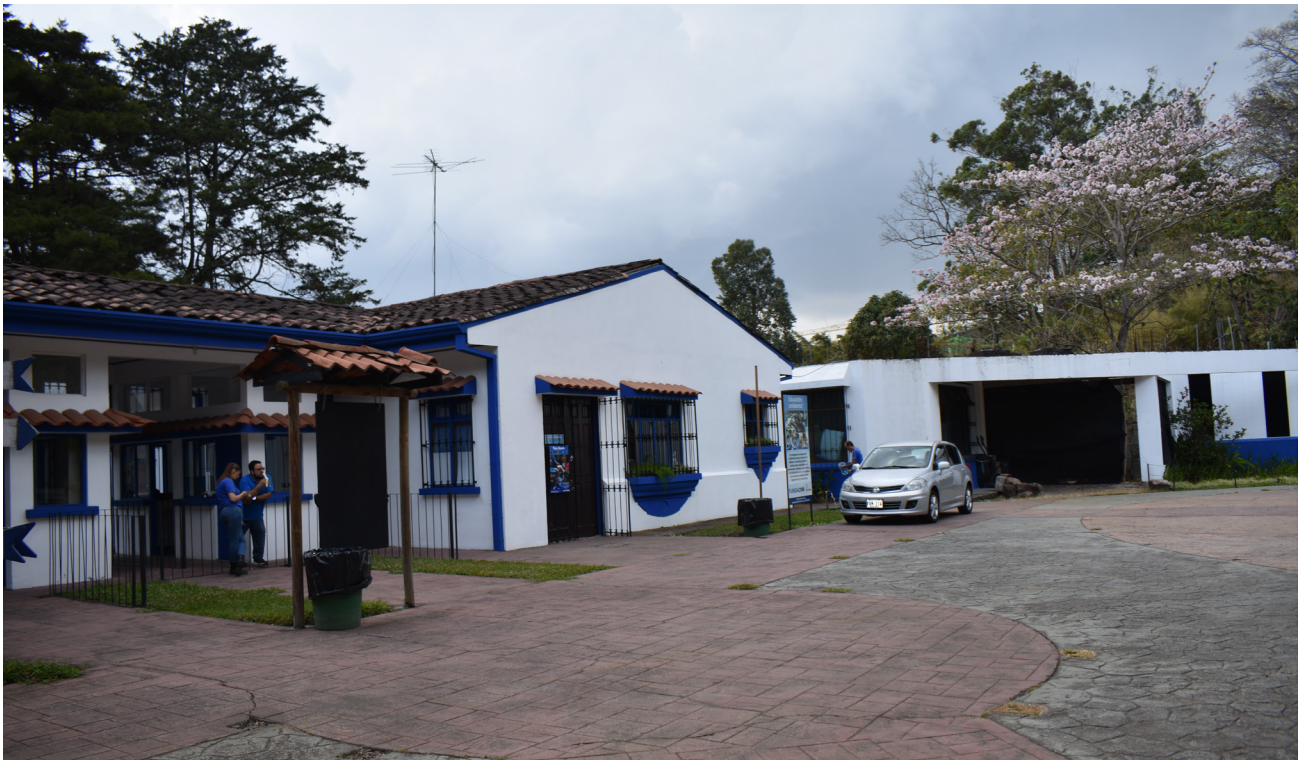
Imagen 3.15: Visualización del estado actual, vista posterior de boleterías y área de talleres. Fuente: Elaboración propia.
