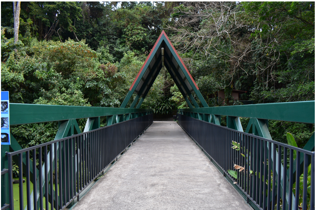
Imagen 1.28: Puente sobre la laguna del Parque Bolívar.
