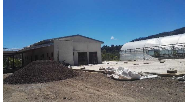
Figura 09. Fotografía de la construcción de las oficinas administrativas del beneficio del café; fecha 28-02-2018.
