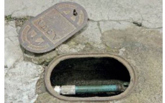
Imagen 23. Reconexión con tuberías PVC
