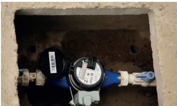
Imagen 24. Reconexión con tuberías PVC
