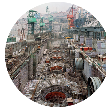
Imagen 1. Represa en construcción
