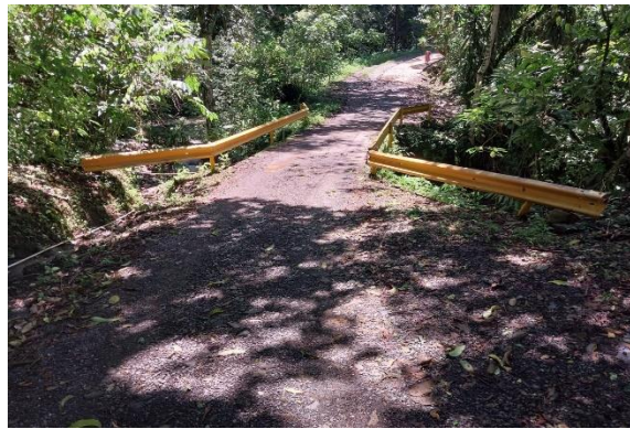
Vista panorámica puente Bajo Murillo
