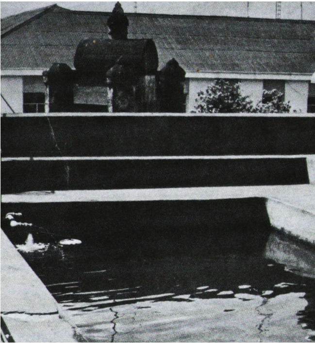
▲ Figura 55: Tanque de agua de la Fábrica.
