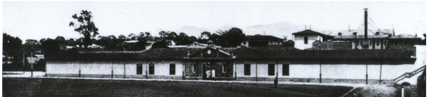
▲ Figura 61: Perspectiva de la fachada oeste de la Fábrica en el año 1909.
