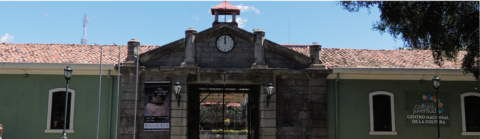
▲ Figura 39: Pabellón administrativo oeste.
