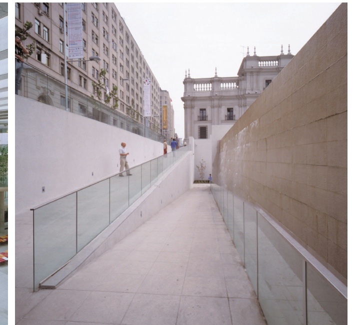
▲ Figura 79: Vista de la rampa de ingreso "Pacífico" (oeste).
