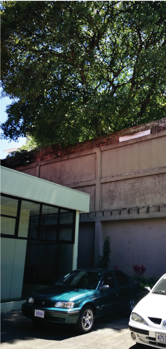
▲ Figura 24: Muro de retención comúnmente utilizado en el conjunto.
