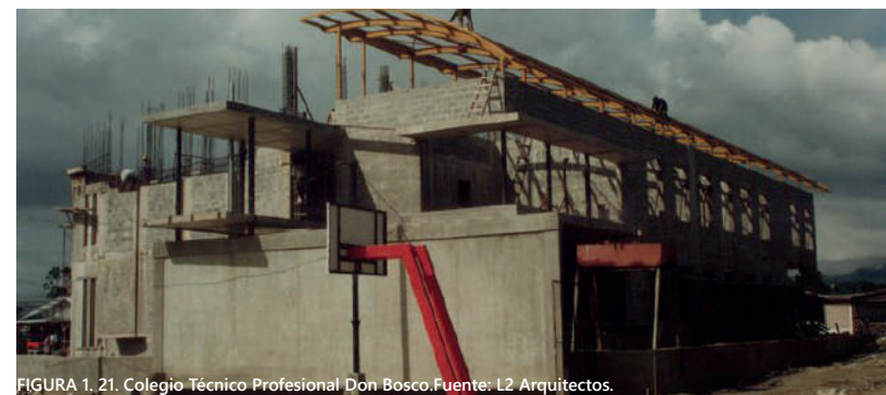
FIGURA 1. 21. Colegio Técnico Profesional Don Bosco.Fuente: L2 Arquitectos.
