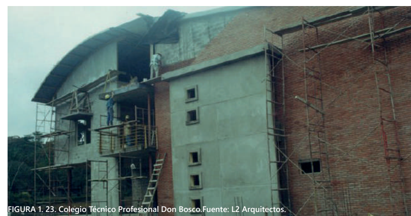
FIGURA 1. 23. Colegio Técnico Profesional Don Bosco.Fuente: L2 Arquitectos.
