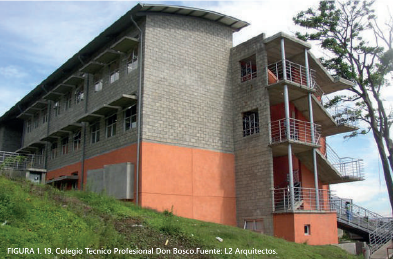
FIGURA 1.19. Colegio Técnico Profesional Don Bosco. Fuente: L2 Arquitectos.
