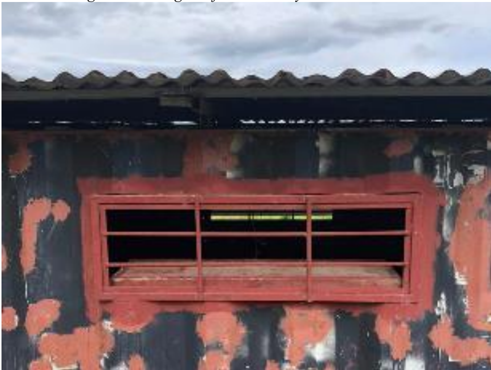
Figura 14. Ventana de la bodega de la finca “El Coyolar”.
