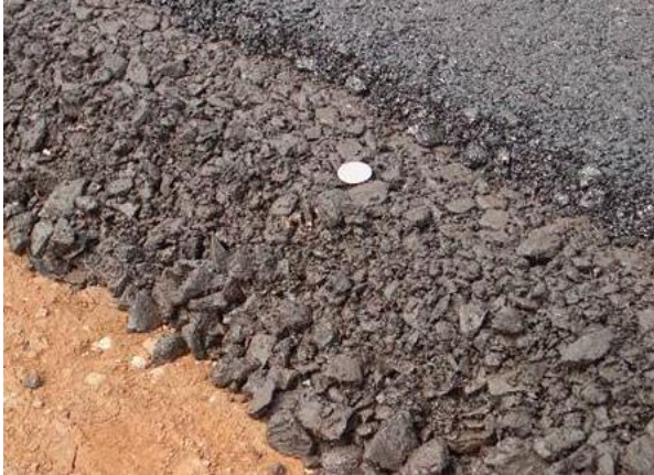
Figura 5. Sección de pavimento semi-rígido con base estabilizada con concreto.
