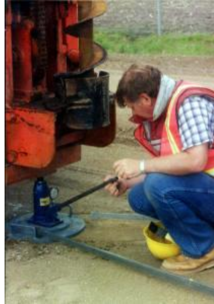
Figura 10. Prueba in situ del plato de carga.
