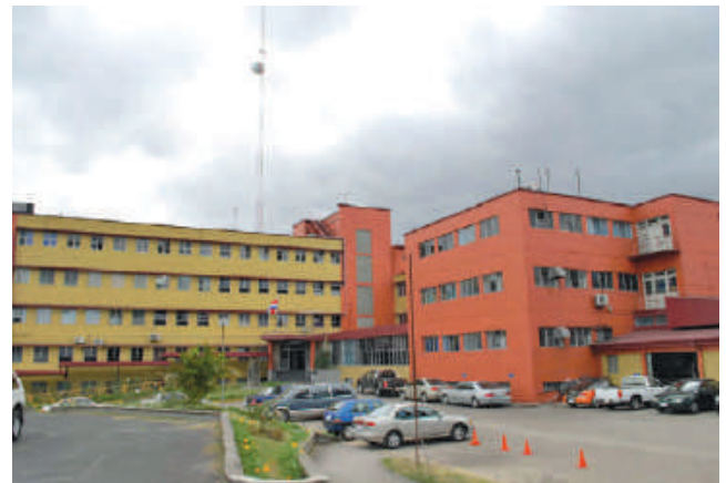
Figura 2.3: Vista del estacionamiento del HNGGRBC Fuente: CCSS
