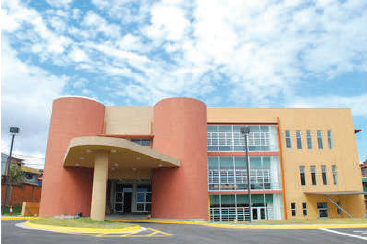
Figura 2.1: Fachada principal del HINGGRBC Fuente: CCSS
