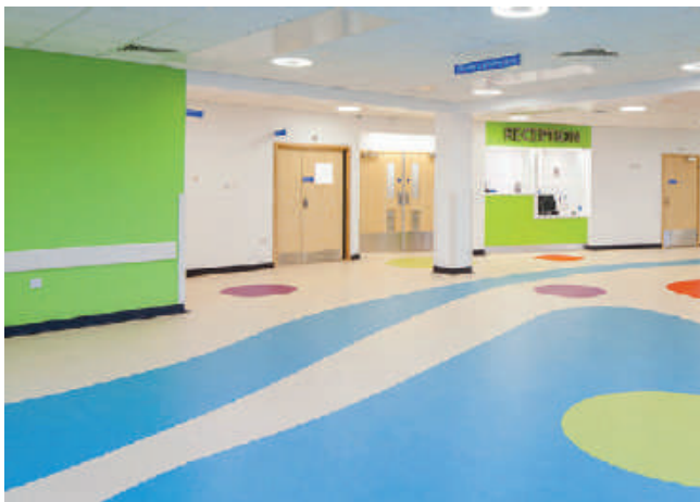
Figura 5.79: Pisos vinílico Fuente: crmcostarica.com
