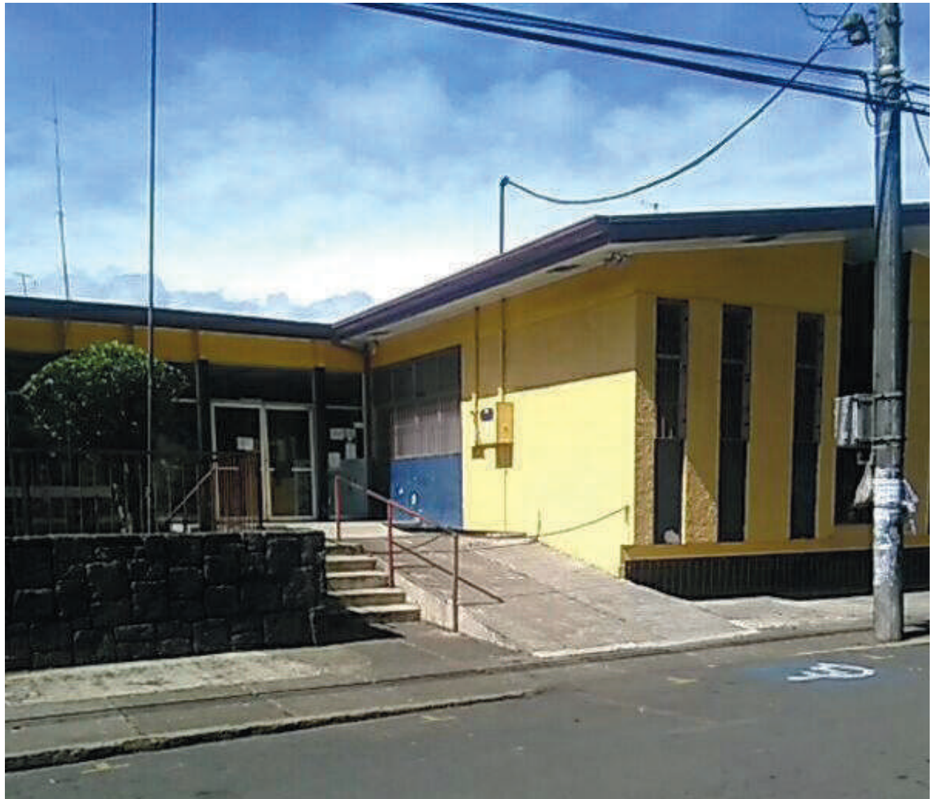
Figura 2.4: Vista frontal del Ebais de Paraíso Fuente: La nación
