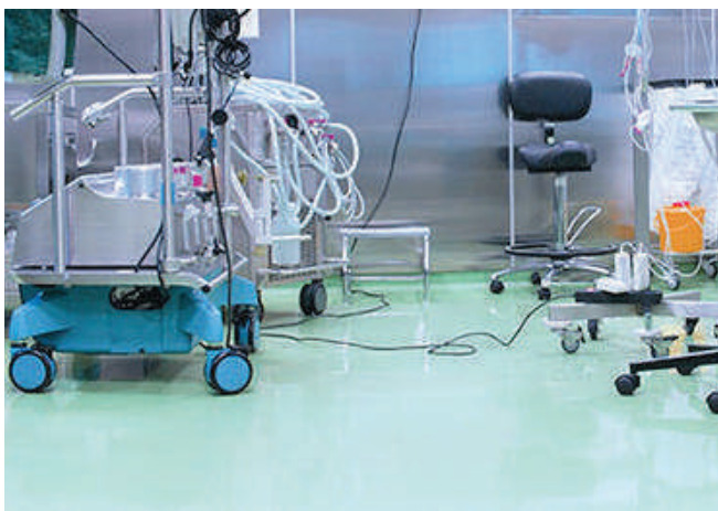
Figura 5.77: Pisos epóxico Fuente: sherwinca.com
