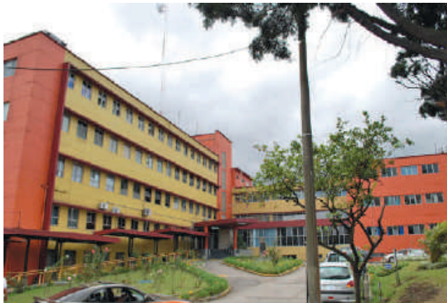
Figura 2.2: Vista interna del HNGGRBC Fuente: CCSS
