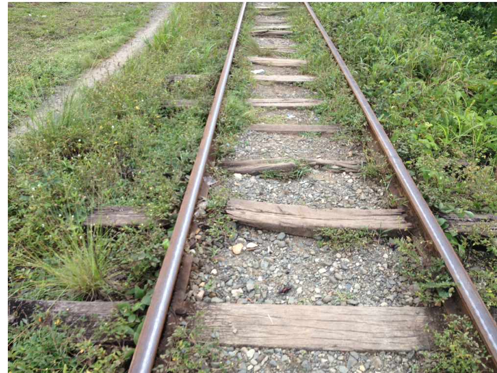
Imagen 94: Vía del tren.
