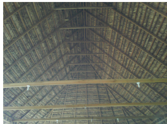
Imagen 148: Estructura del techo de palma.
