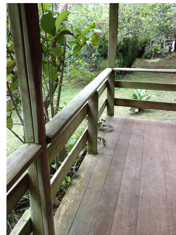
Imagen 50: Terraza de la cabina.
