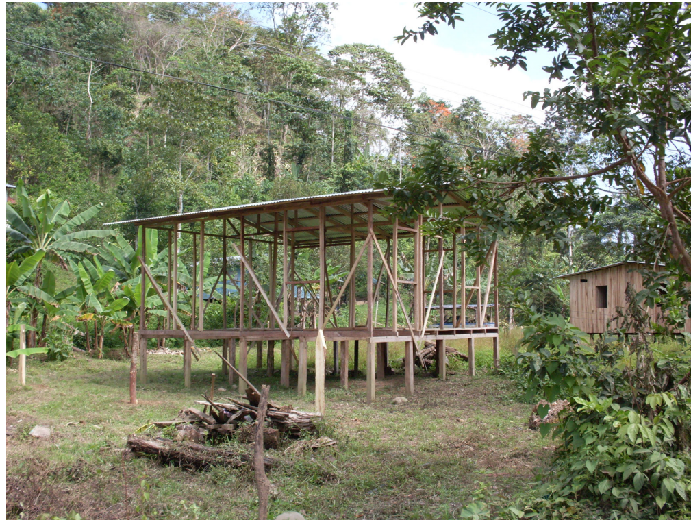
Imagen 109: Técnicas constructivas de las casa encontradas en Burrico.
