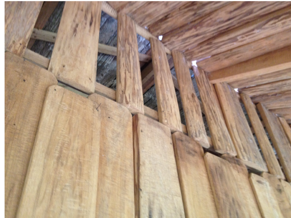
Imagen 46: Acabados en las cabinas, para ventilación.
