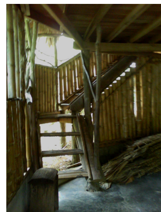
Imagen 149: Paredes de bambú.
