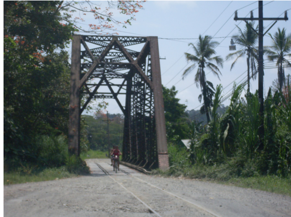
Imagen 10: Puente metálico en Río Bananito.
