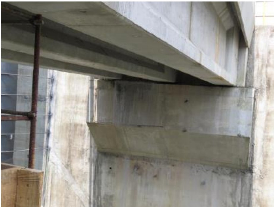
Figura 22. Fotografía de la superestructura.
