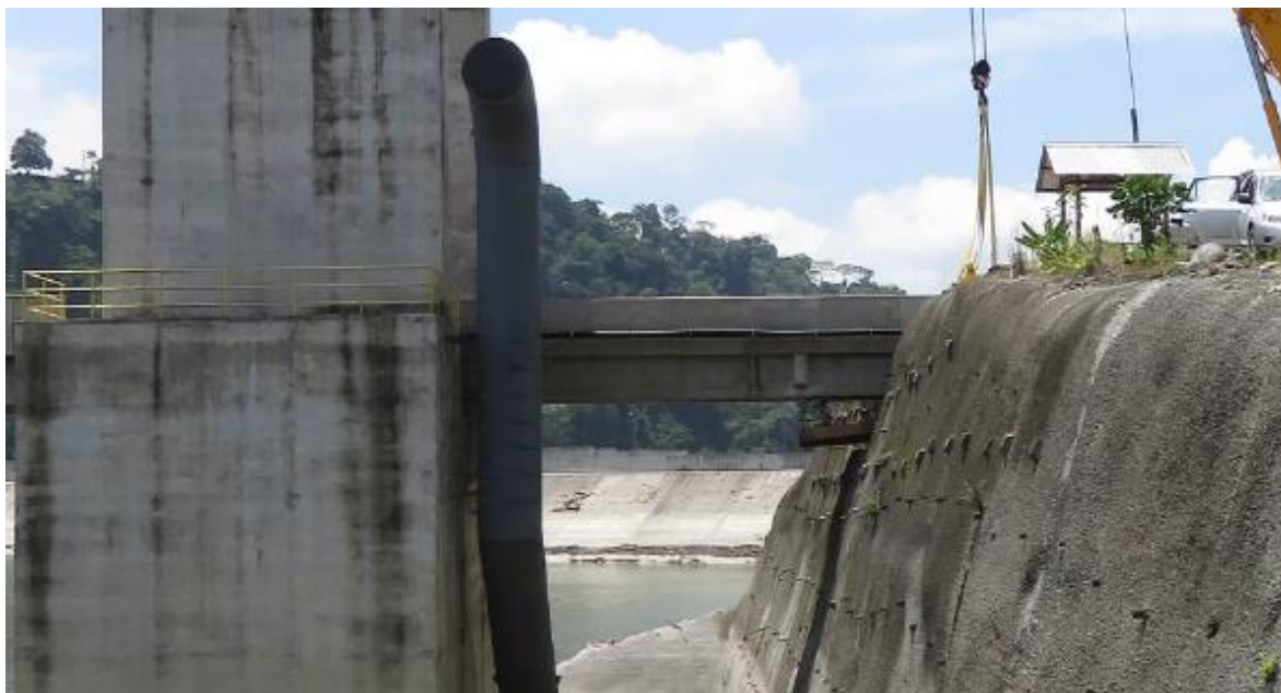
Figura 23. Fotografía lateral de la estructura.
