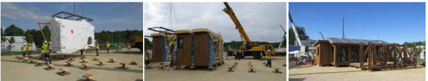
▲ Imagen A- 15 Construcción Casa Fénix Fuente Solar Decathlon, 2014
