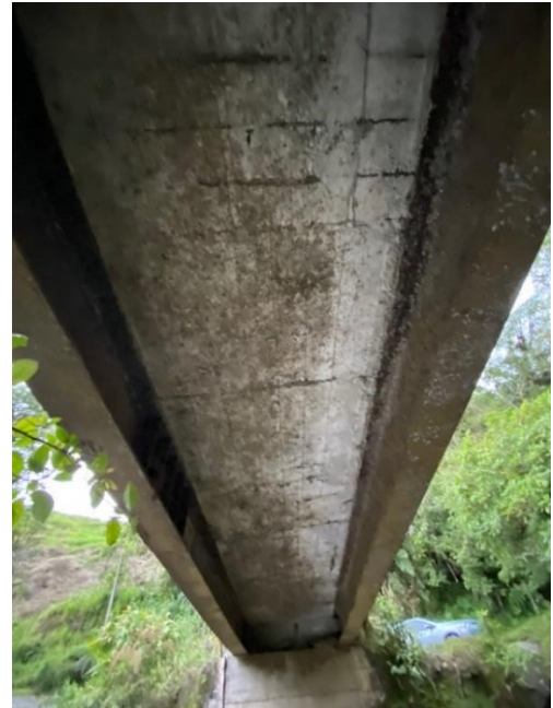
Figura A61. Parte inferior de la losa. Autoría propia.
