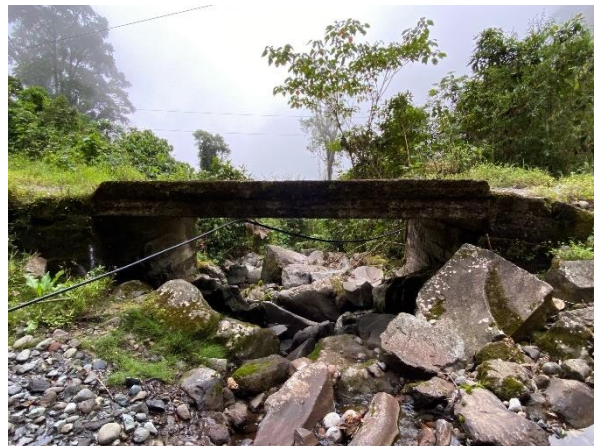
Figura A17. Fotografía de perfil del Puente Río Lajitas 2. Autoría propia.
