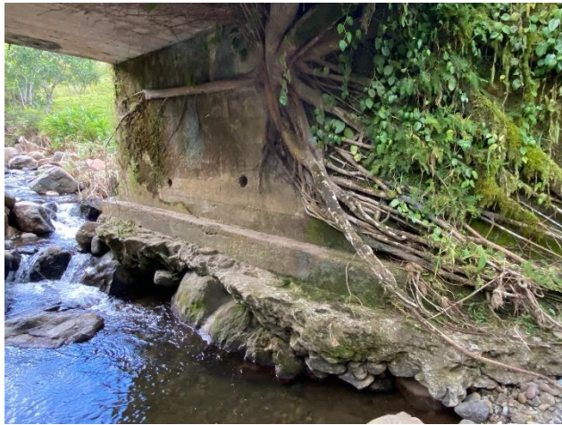
Figura A7. Vista del bastión B2. Autoría propia.
