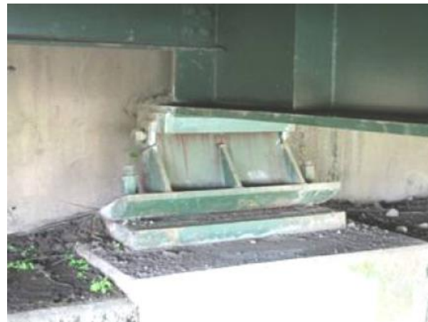
Figura 60. Inclinación en el apoyo (MOPT, 2007).
