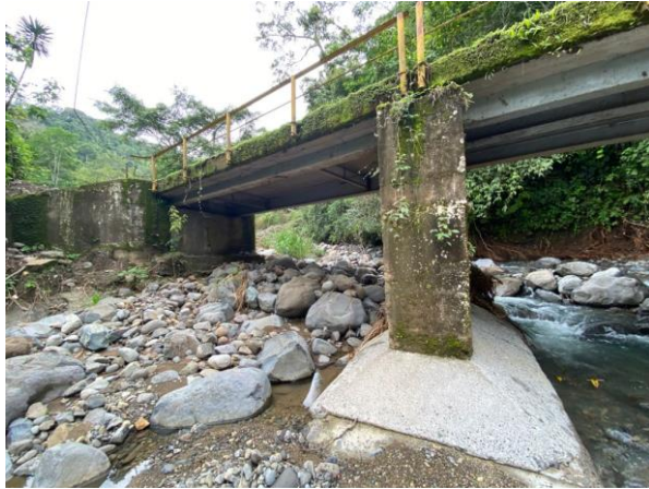
Figura A100. Fotografía de perfil del Puente Cruce con San Joaquín. Autoría propia.
