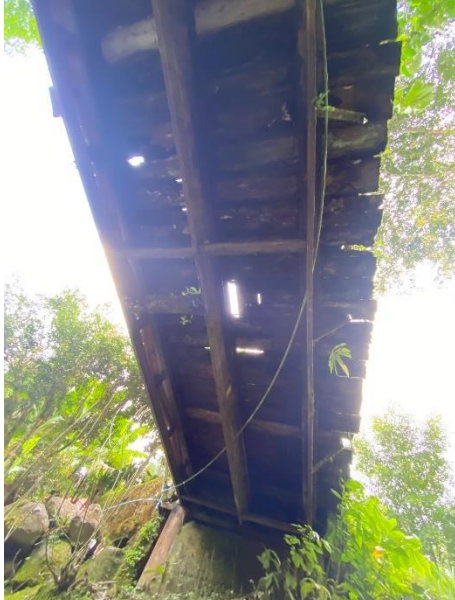
Figura A121. Parte inferior de la losa. Autoría propia.
