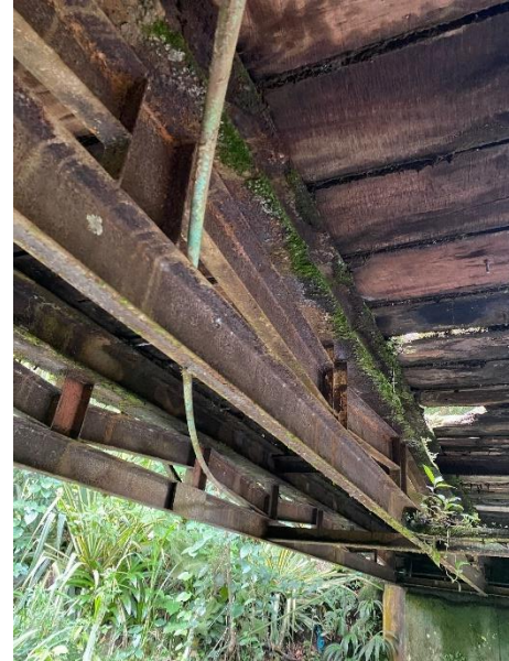
Figura A122. Acercamiento de las vigas principales. Autoría propia.
