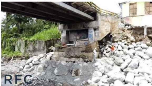
Figura 80. Escollera realizada en el Puente Blanco (RFC Constructora, 2021).
