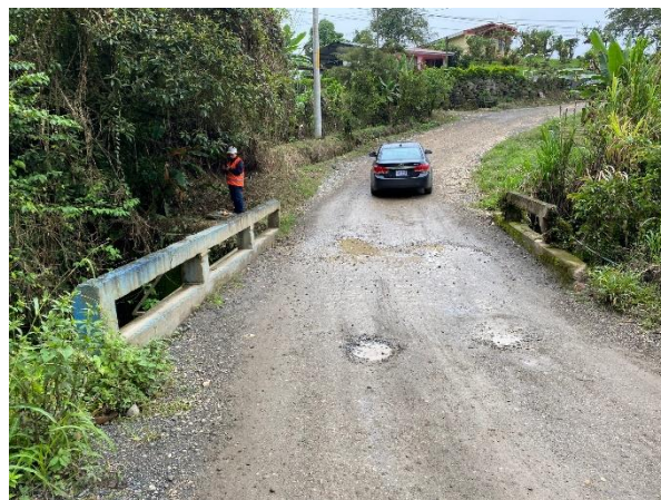
Figura A128. Obstrucción de las juntas de expansión. Autoría propia.
