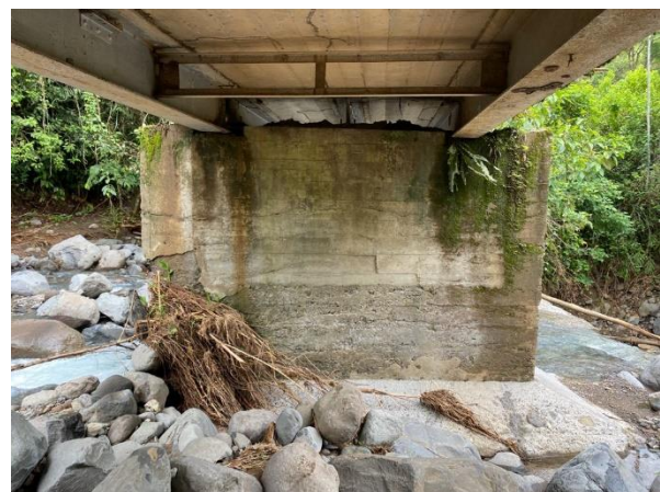
Figura A109. Lado contrario de la Pila P1. Autoría propia.
