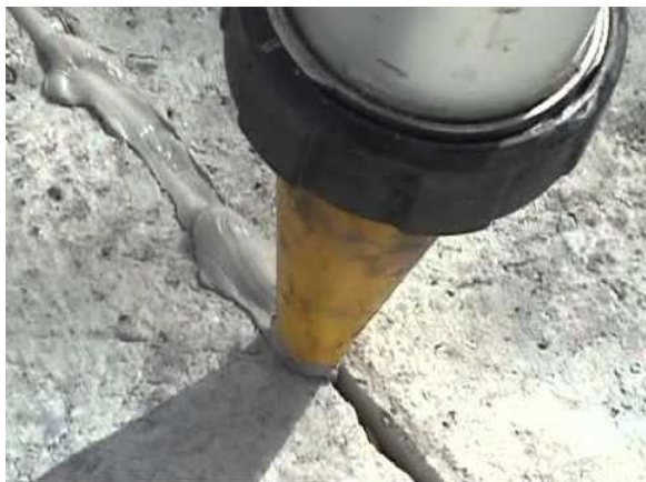
Figura 81. Sellado de grieta mediante inyección de resina expóxica (Structuralia, 2016).
