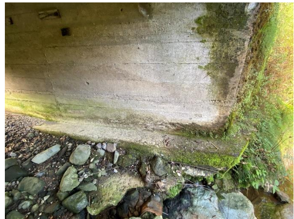
Figura A76. Vista del bastión B2. Autoría propia.
