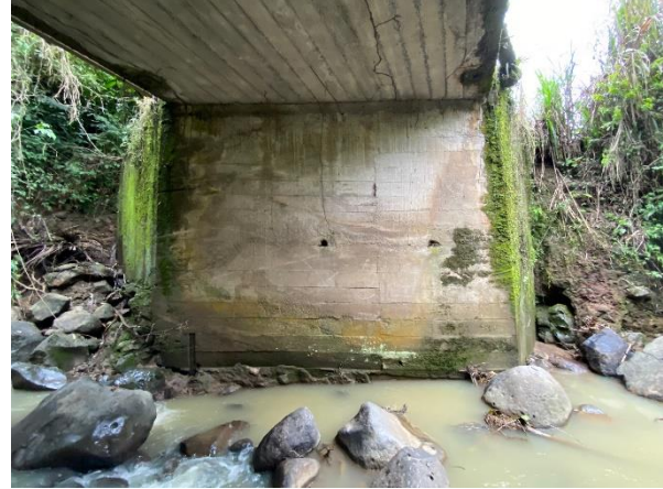
Figura A131. Vista del bastión B2. Autoría propia.
