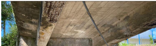
Figura A28. Vista inferior de parte de la losa. Autoría propia.
