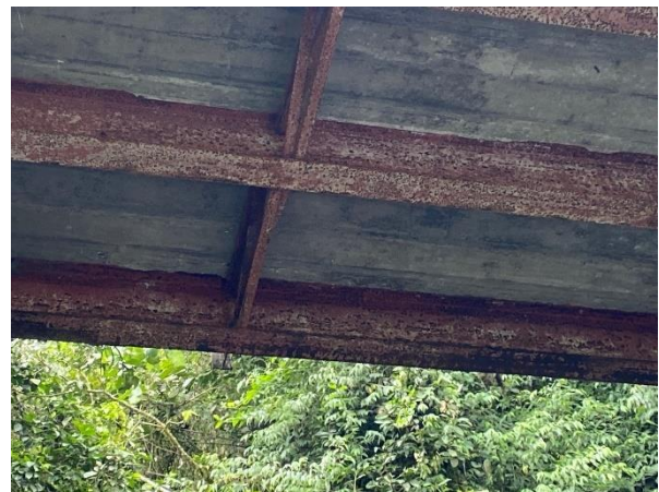
Figura A47. Acercamiento de las vigas principales. Autoría propia.
