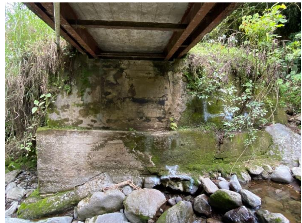
Figura A15. Aletón derecho del bastión B1. Autoría propia.
