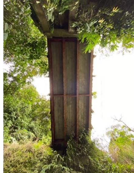
Figura A46. Vista inferior de la losa. Autoría propia.
