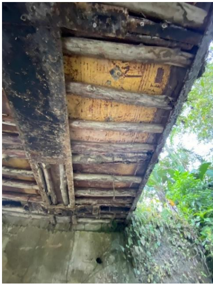
Figura A95. Acercamiento de las vigas principales. Autoría propia.
