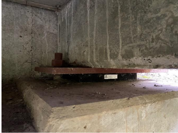
Figura A91. Fotografía de los apoyos del Puente Río Torito. Autoría propia.
