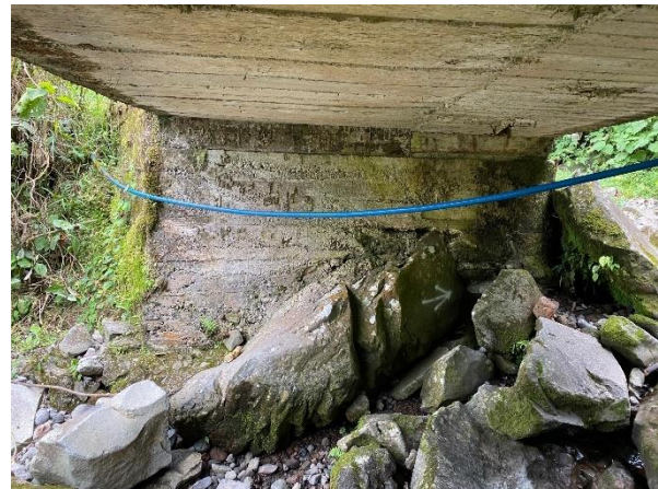
Figura A21. Vista inferior de parte de la losa. Autoría propia.
