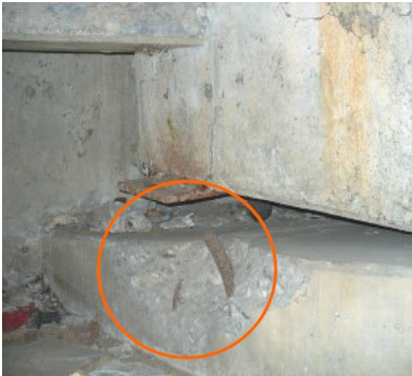
Figura 58. Pernos de anclaje cortados (MOPT, 2007).
