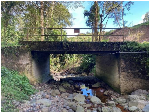
Figura A71. Fotografía de perfil del Puente Virtudes. Autoría propia.
