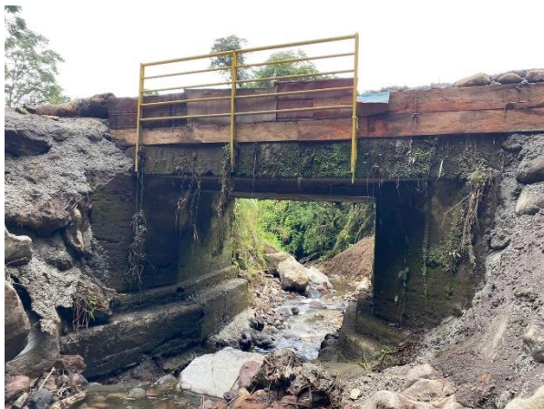
Figura A33. Fotografía de perfil del Puente Porosal 1. Autoría propia.
