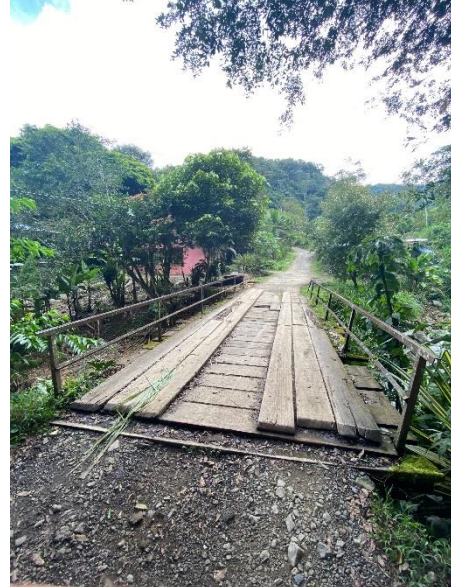
Figura A120. Obstrucción de la junta J1. Autoría propia.
