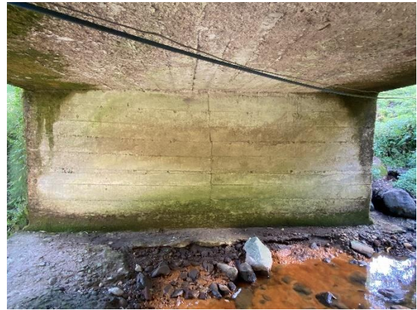
Figura A75. Vista del bastión B1. Autoría propia.
