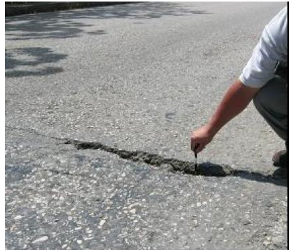
Figura 28. Sobrecapa en el pavimento (MOPT, 2007).
