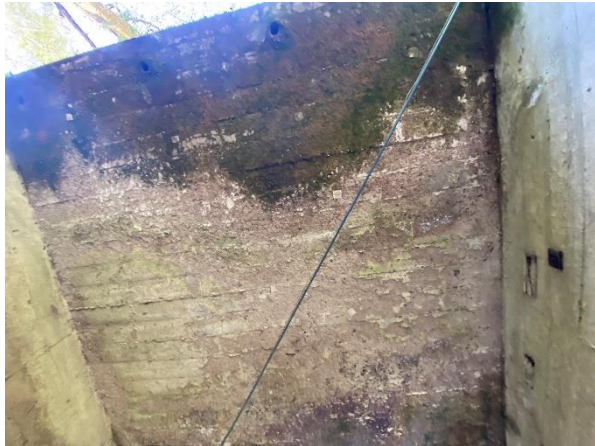
Figura A74. Vista inferior de parte de la losa. Autoría propia.
