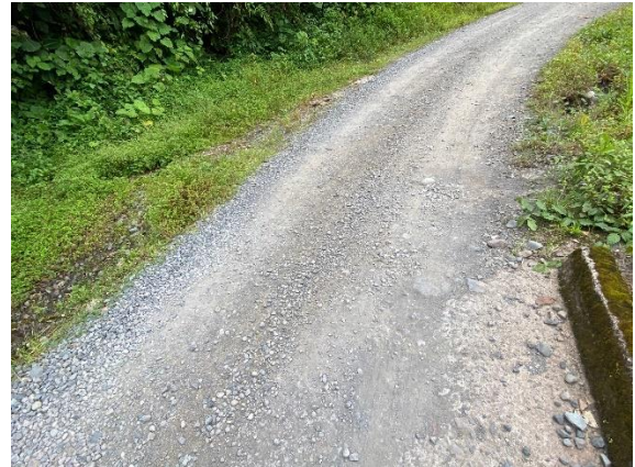
Figura A20. Obstrucción de las juntas de expansión. Autoría propia.
