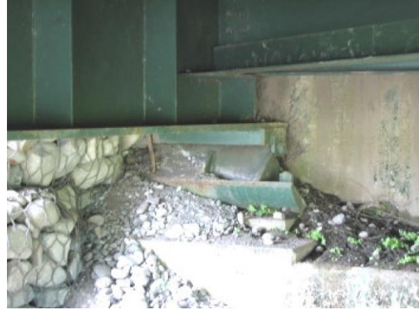
Figura 59. Deformación en el apoyo (MOPT, 2007).
