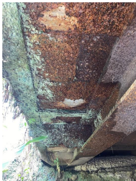
Figura A134. Acercamiento de las vigas principales. Autoría propia.
