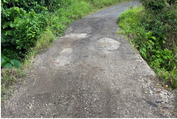
Figura A94. Obstrucción de las juntas de expansión. Autoría propia.
