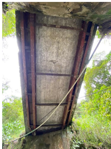
Figura A12. Vista inferior de la losa. Autoría propia.
