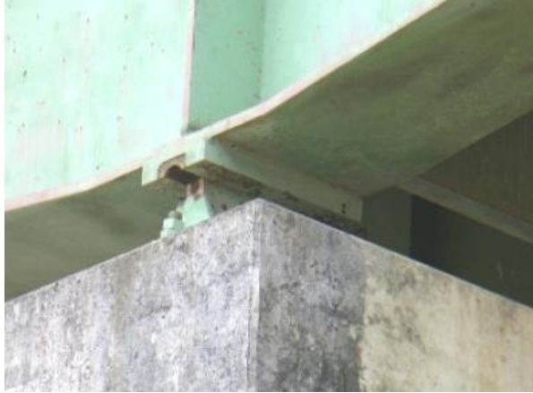
Figura 61. Movimiento del apoyo (MOPT, 2007).
