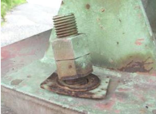
Figura 57. Deformación de perno en apoyo (MOPT, 2007).
