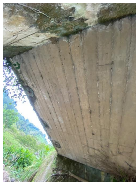
Figura A5. Parte inferior de la losa. Autoría propia.
