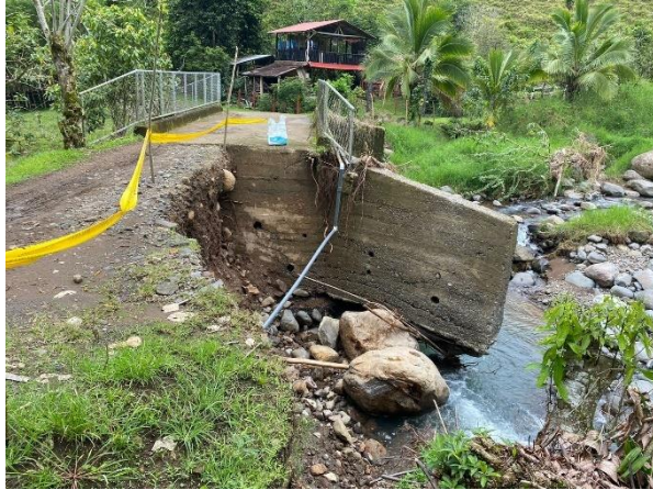
Figura A115. Talud de relleno del Bastión B1. Autoría propia.
