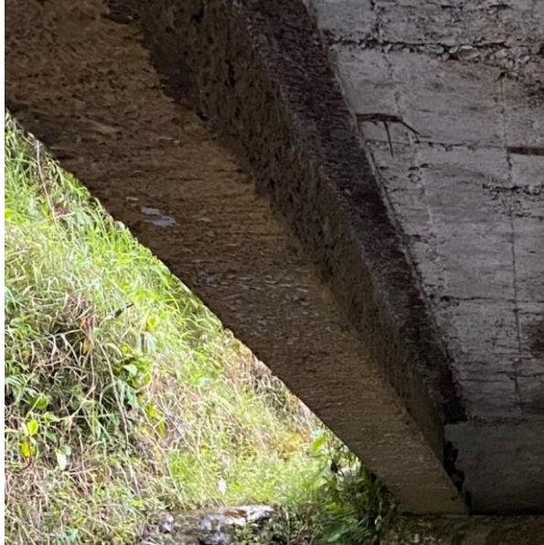
Figura A62. Acercamiento de las vigas principales. Autoría propia.
