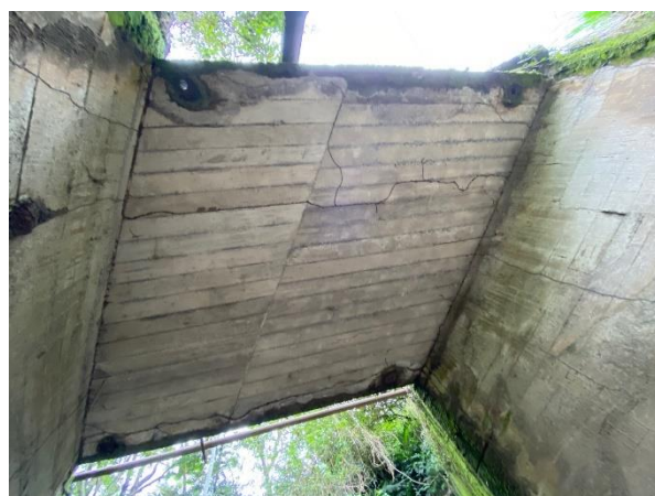
Figura A129. Vista inferior de parte de la losa. Autoría propia.
