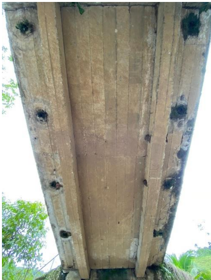
Figura A113. Vista inferior de la superestructura. Autoría propia.
