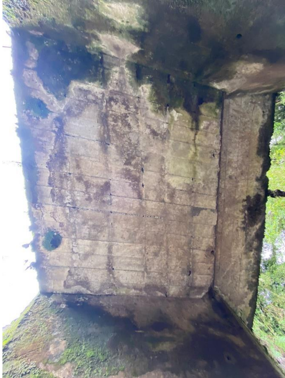
Figura A35. Vista inferior de la losa. Autoría propia.
