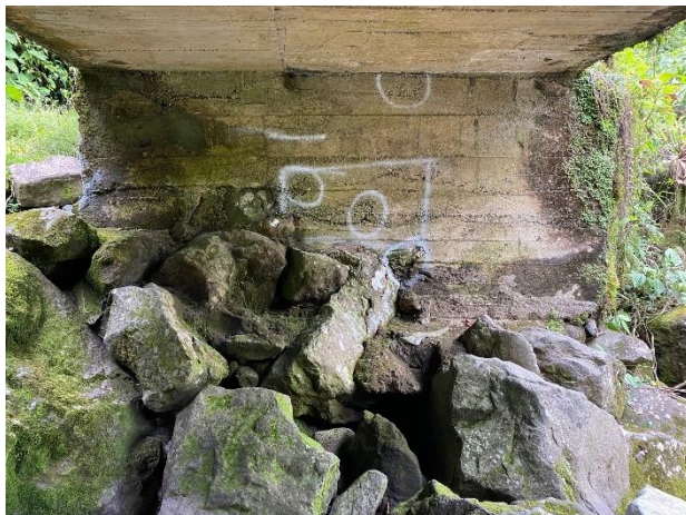
Figura A22. Vista del bastión B2. Autoría propia.
