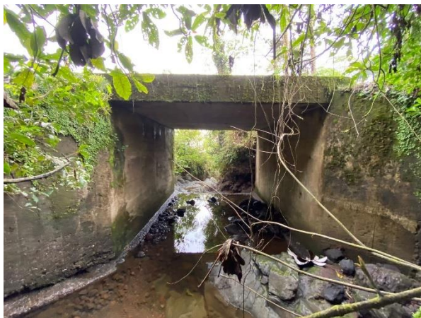
Figura A38. Fotografía de perfil del Puente Porosal 2. Autoría propia.
