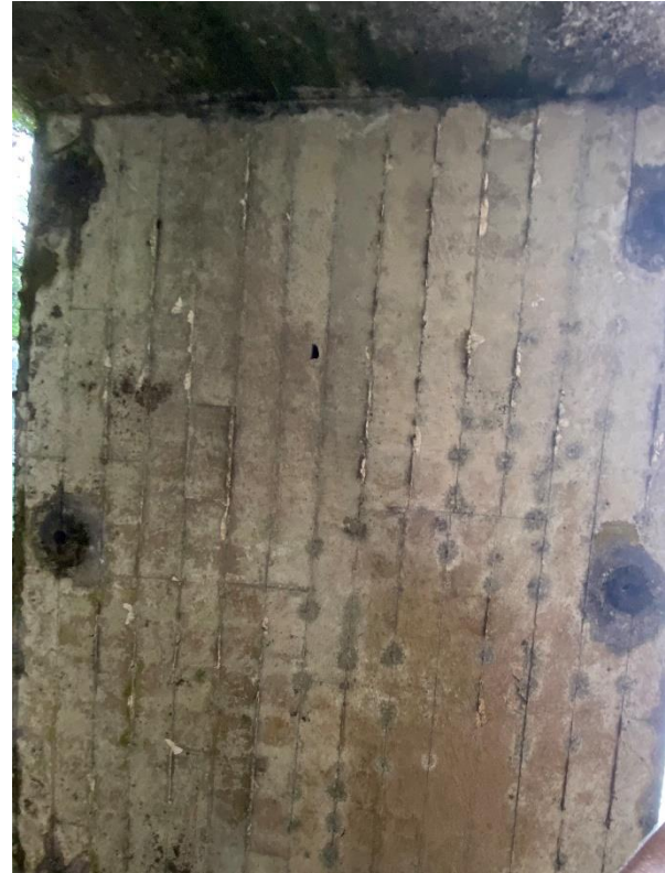
Figura A81. Vista inferior de parte de la losa. Autoría propia.
