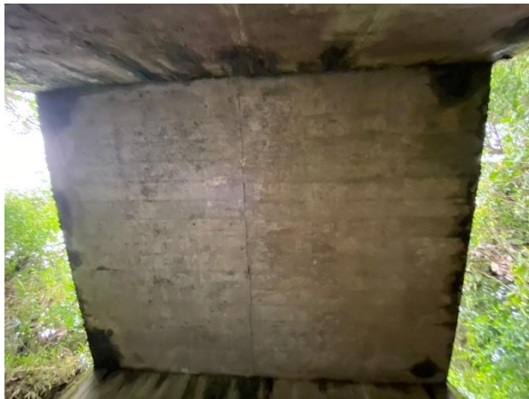
Figura A41. Vista inferior de la losa. Autoría propia.
