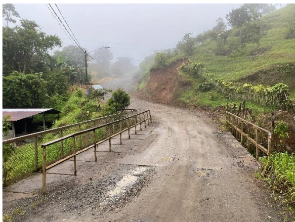
Figura A132. Fotografía del Puente Quebrada Grande. Autoría propia.
