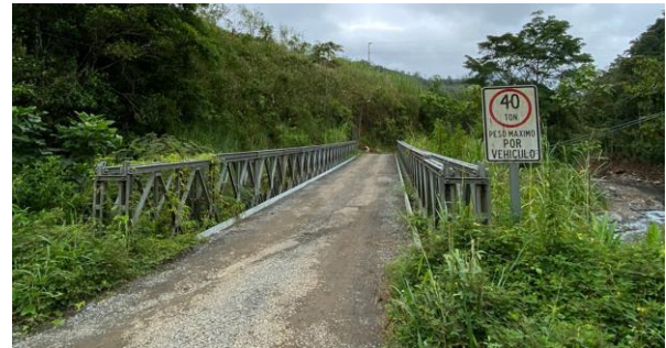
Figura A84. Fotografía del Puente Río Culebra. Autoría propia.
