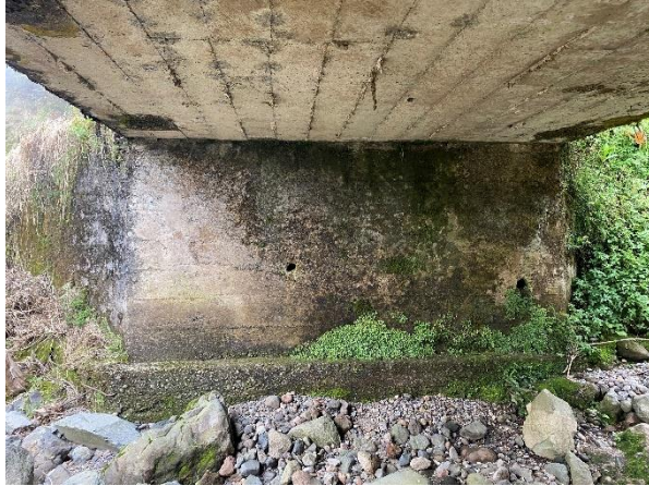
Figura A82. Vista del bastión B1. Autoría propia.
