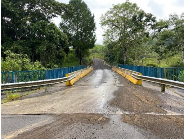
Figura A87. Fotografía longitudinal del Puente Río Torito. Autoría propia.
