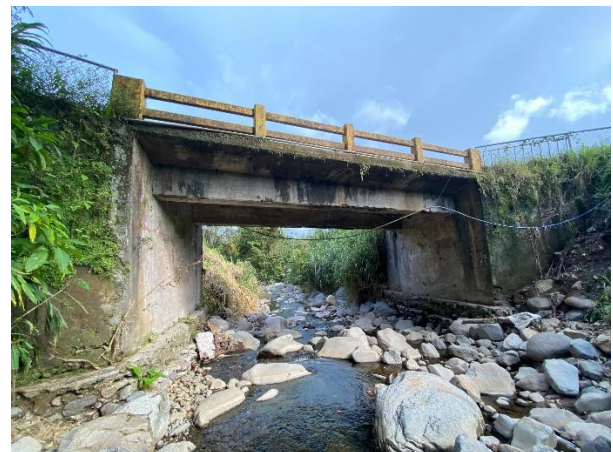
Figura A23. Fotografía de perfil del Puente San Antonio. Autoría propia.
