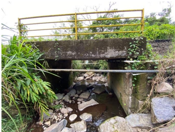
Figura A51. Fotografía de perfil de la alcantarilla Cruce con San Antonio. Autoría propia.
