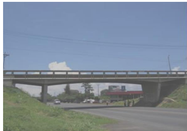
Figura 8. Ejemplo de una superestructura tipo marco rígido. (MOPT, 2007).
