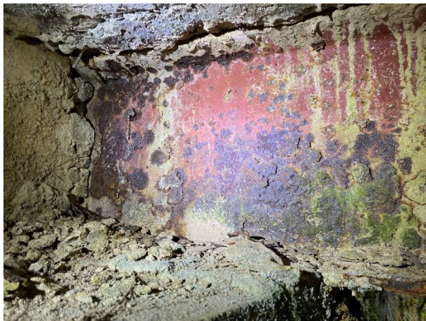
Figura A13. Acercamiento del extremo de las vigas principales. Autoría propia.
