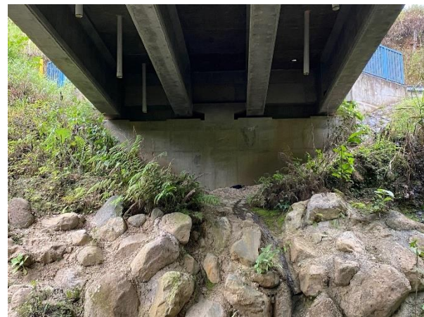
Figura A90. Fotografía del bastión B1 del Puente Río Torito. Autoría propia.
