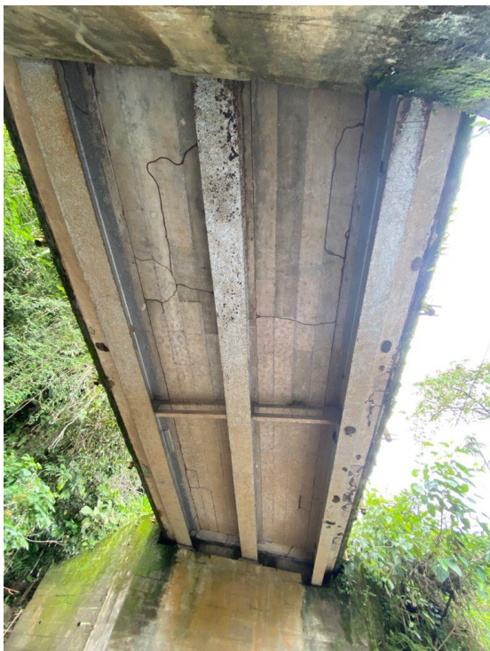
Figura A104. Acercamiento de las vigas principales. Autoría propia.
