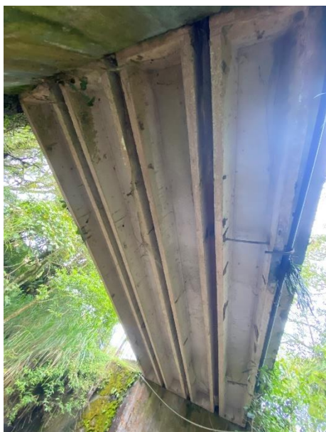
Figura A68. Acercamiento de las vigas principales. Autoría propia.
