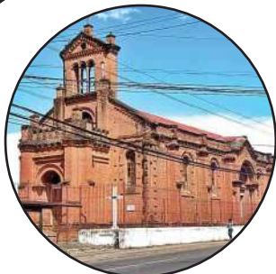
Figura 2.125. Fotografía análisis red urbana/ Fuente: https://maritzacartin.files.wordpress.com/2016/10/iglesia-de-san-francisco2.jpg?w=640
