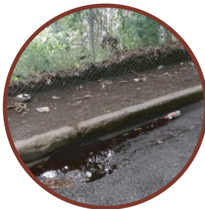
Figura 2.253.Visual estado de aceras. Fuente: Fuente propia.
