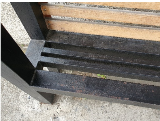
Figura 16: Pintura sobre metal oxidado. Fuente: Elaboración propia.
