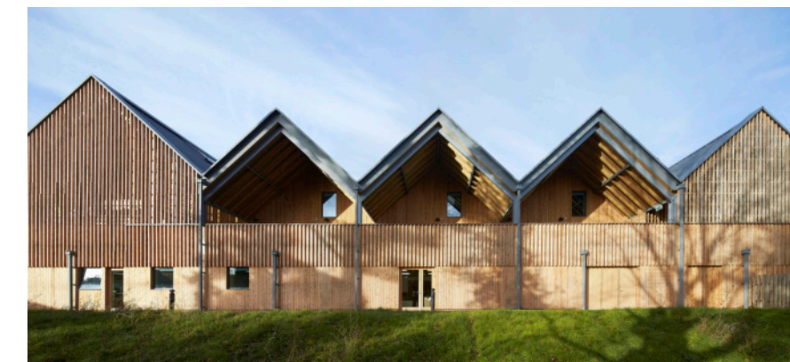
Imagen 30. Fachada de la Escuela de Bedales. Tomada de: Plataforma Arquitectura
