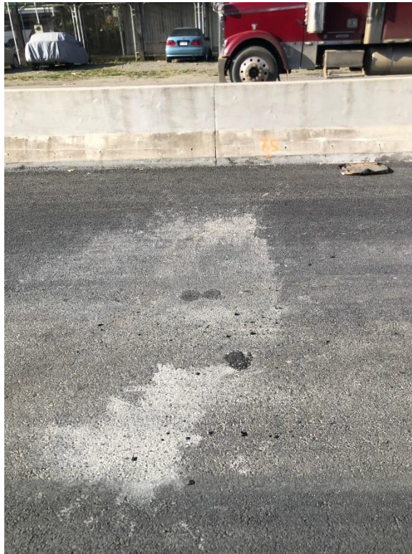
Figura 39. Núcleos con mezcla asfáltica
