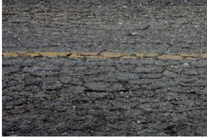
Figura 3. Falla por fatiga "cuero de lagarto" Fuente: Zevallos, 201
