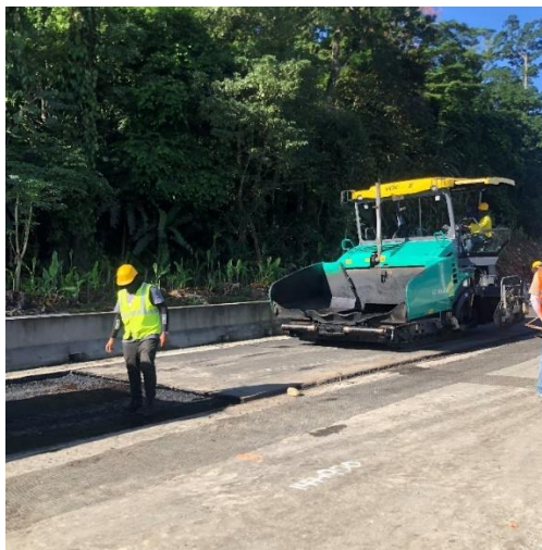
Figura 5. Equipo de asfalto, Finisher
