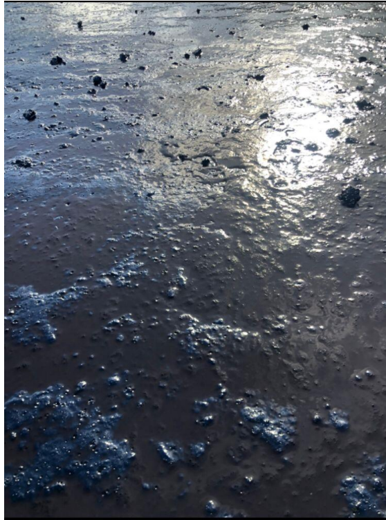
Figura 41. Rompimiento de la emulsión
