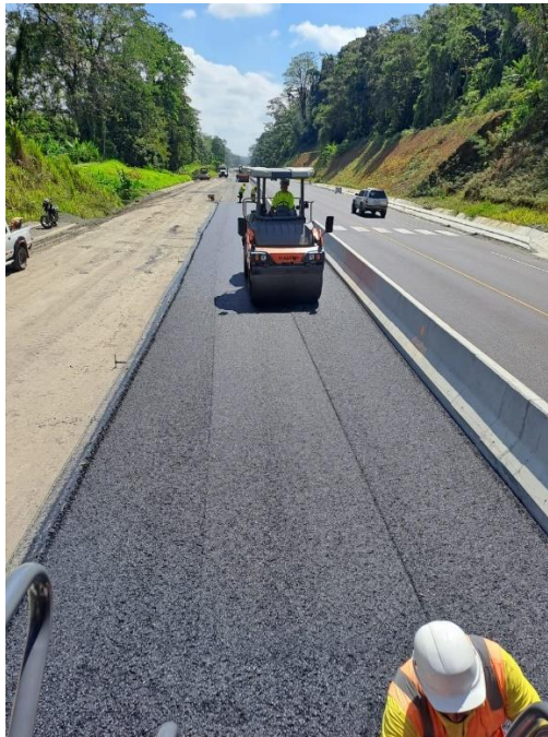
Figura 8. Compactación con rodillo
