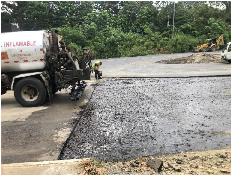
Figura 6. Camión distribuidor de asfalto
