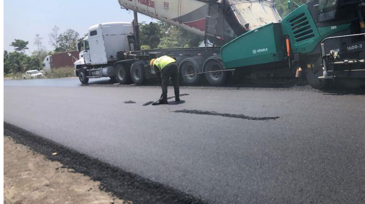
Figura 30. Colocación de mezcla sobre capa densificada
