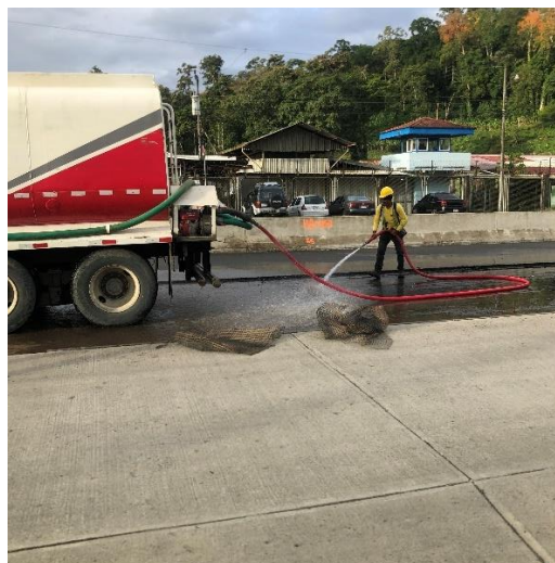
Figura 12. Camión distribuidor de agua
