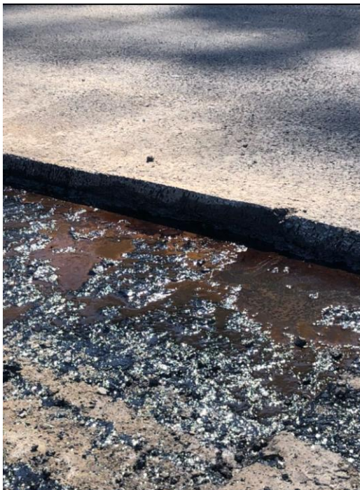
Figura 35. Exceso de riego de liga
