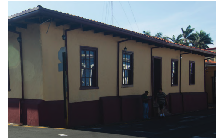
12 Ventanas de fachada restaurada
