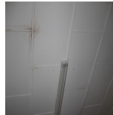
81 Visual del cielo raso d
