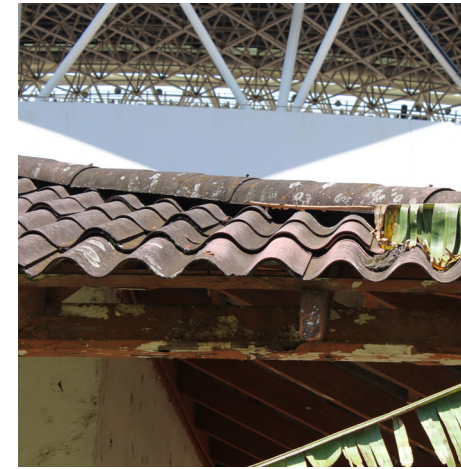
31 Viga perimetral de amarre
