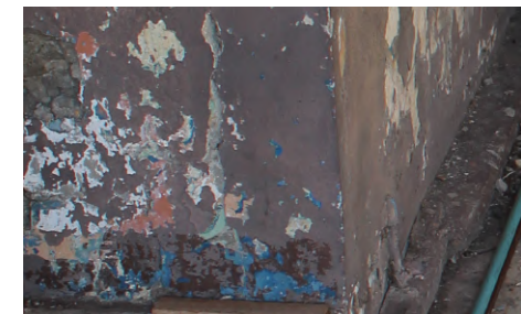
50 Pared parte inferior b
