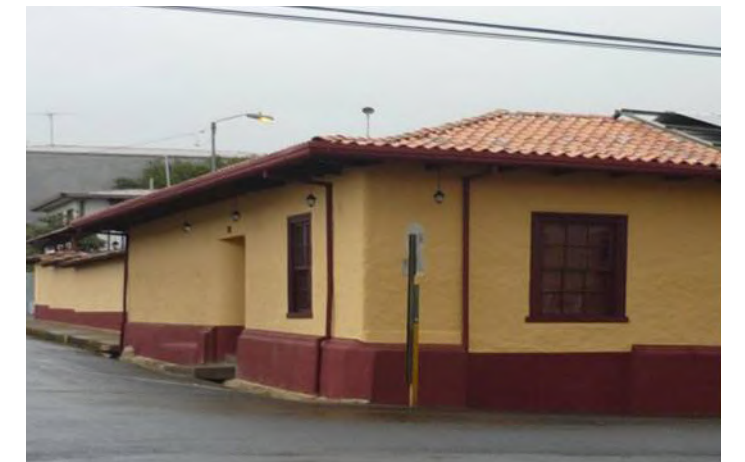
13 Esquina de la fachada restaurada
