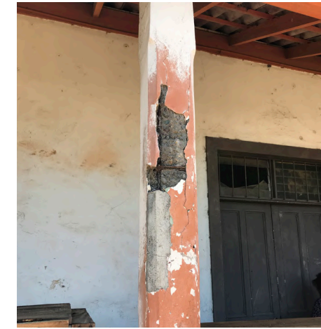
34 Columnas de hormigón
