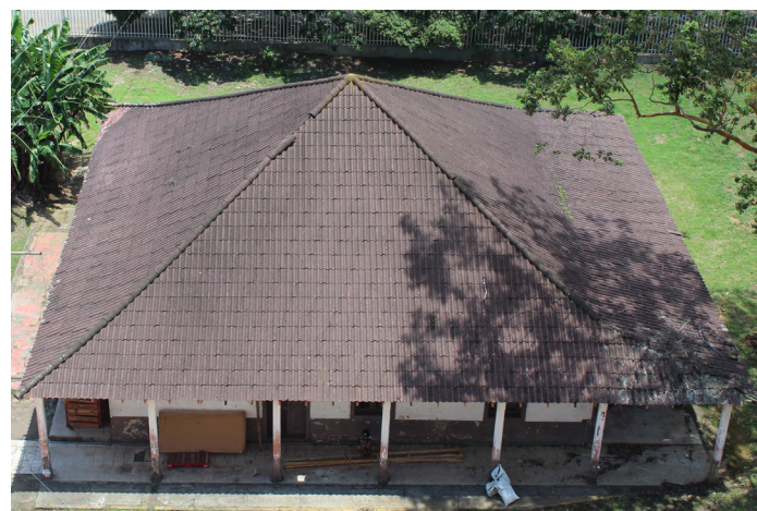
57 Techo lados Oeste, Norte y Sur
