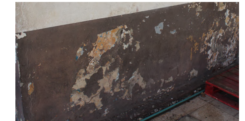
46 Pared parte inferior b
