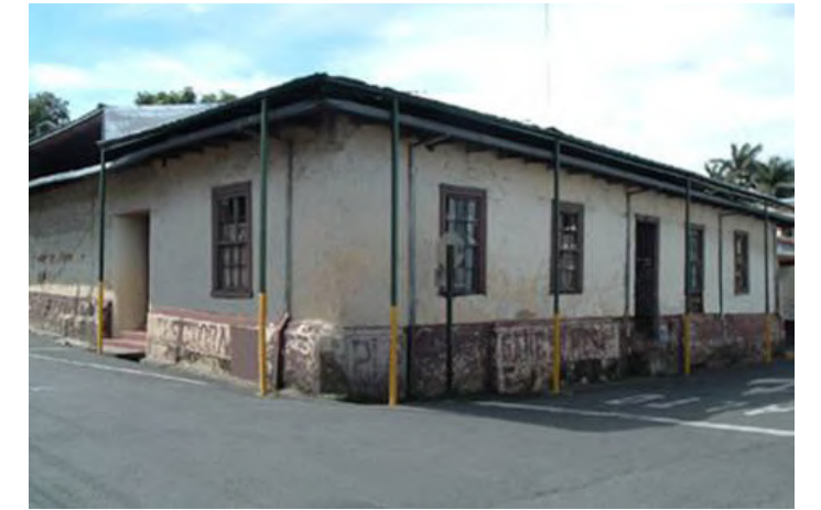
11 Esquina de la fachada
