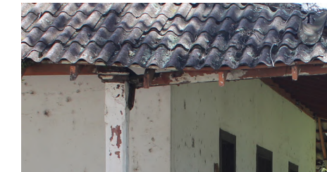
45 Viga perimetral a
