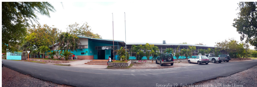
Fotografía 19. Fachada principal de UTN sede Liberia.
