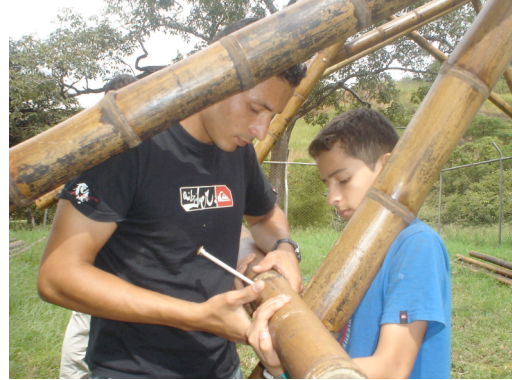
Figura 20. Unión de clavador y Marco
