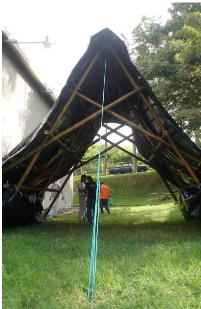
Figura 34. Tensor externo en el Arenal
