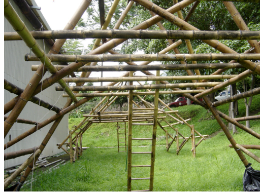
Figura 32. Detalle de la Escalera
