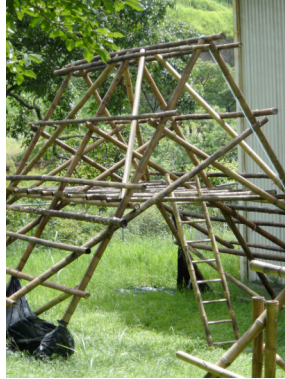
Figura 31. Vista de la Escalera
