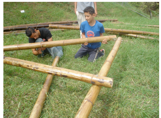
Figura 6. Atornillado del Marco
