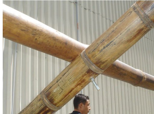
Figura 22. Sobrante de tornillo en clavador y Marco
