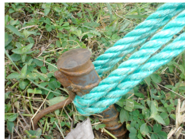
Figura 33. Detalle del Tensor
