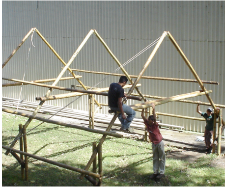
Figura 13. Tensores en el Miravalles
