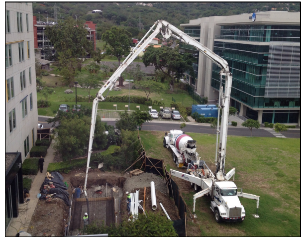
Fig. 53 Chorrea de la losa del fondo de la piscina
