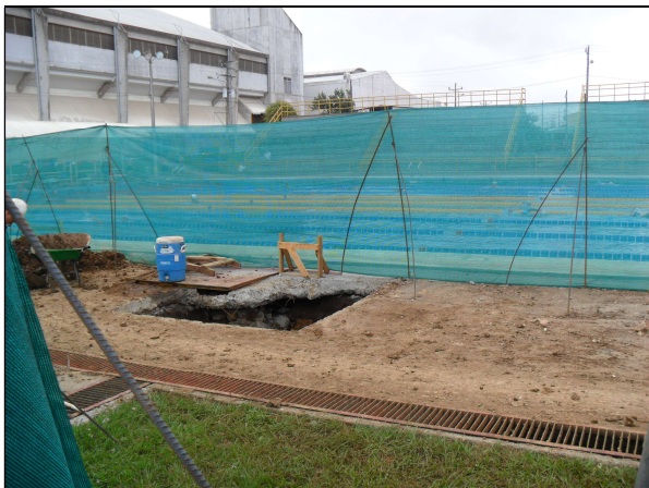
Fig. 28 Construcción de placa de fundación para el techado
