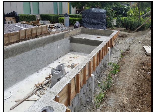
Fig. 69 Levantado de muros de piscina
