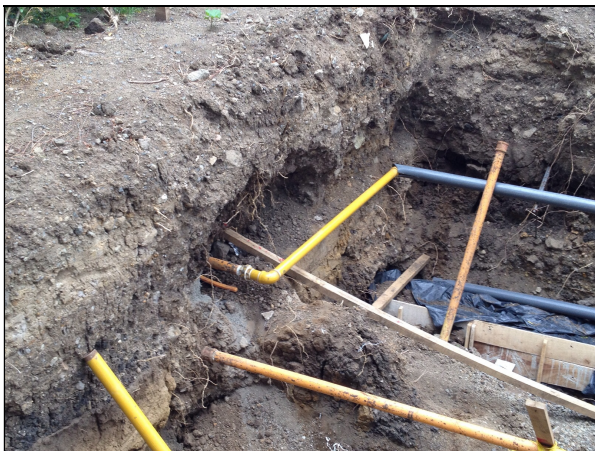
Fig. 50 Excavación de la zona donde estaría ubicada la piscina.
