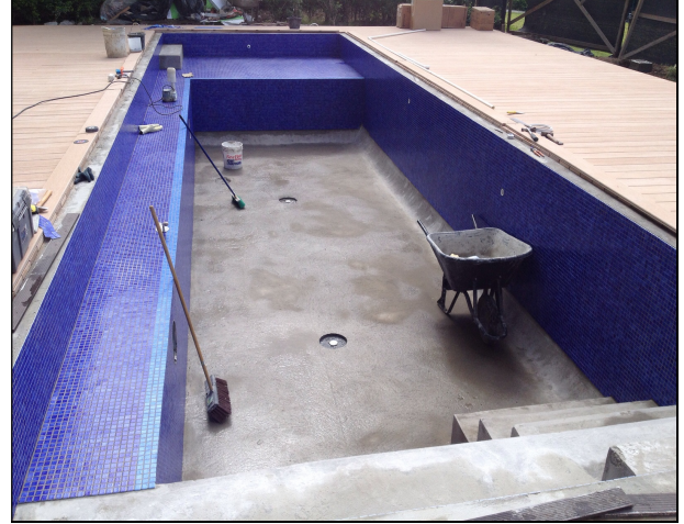
Fig. 58 Colocación de vitrocerámica
