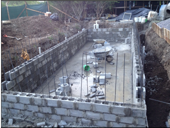
Fig. 56 Levantado de muros
