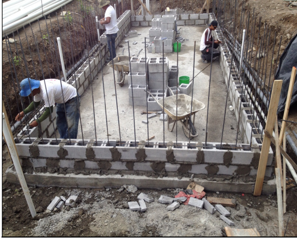
Fig. 55 Levantado de los muros laterales en mampostería.
