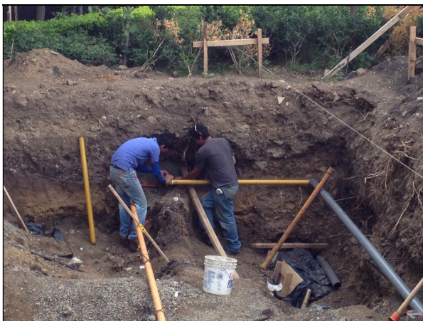
Fig. 51 Re instalación de tubería existente
