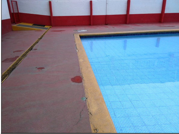
Fig. 36 Vista de una de las esquinas de la piscina
