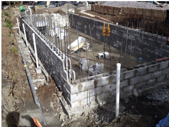
Fig. 68 Levantamiento de muros de piscina de Hotel Aloft
