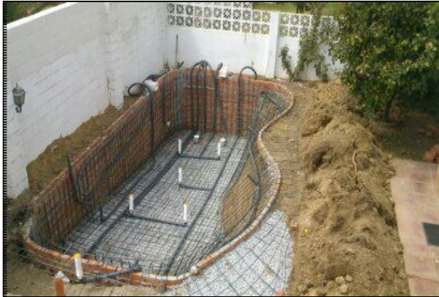
Fig. 10 Colocación de armadura y previstas mecánicas
