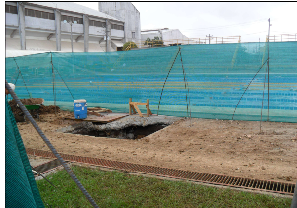
Fig. 63 Construcción de placa de cimentación del techo
