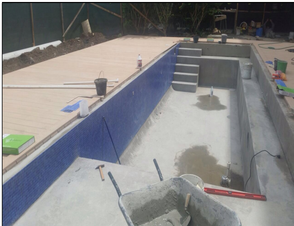
Fig. 57 Construcción de escaleras y grada
