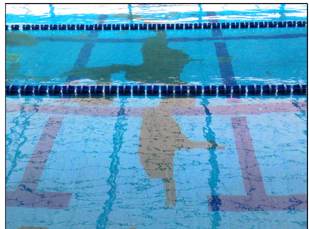
Fig. 25 Zona de agrietamiento tanto ya tratado como nuevo sin tratamiento
