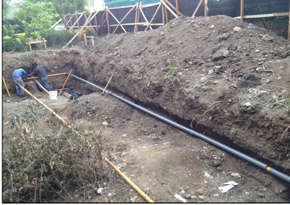
Fig. 70 Excavación de la zona del depósito
