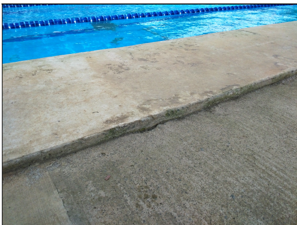
Fig. 22 Deformación en uno de sus lados
