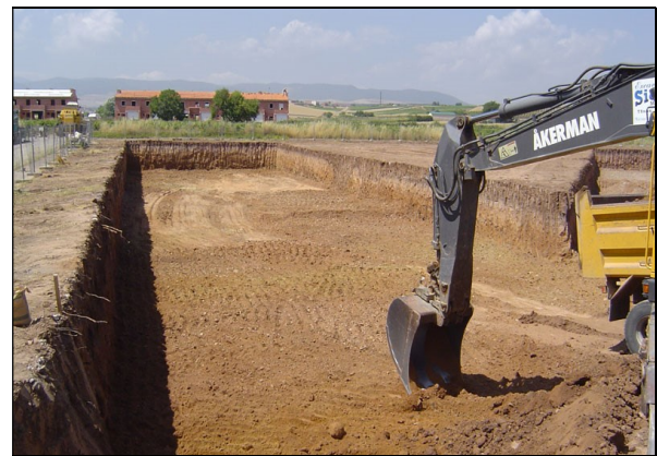
Fig. 9 Excavación del vaso
