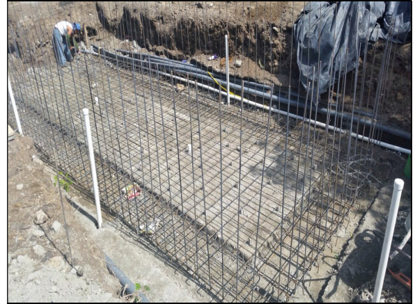
Fig. 52 Colocación de previstas mecánicas y armado del refuerzo estructural.
