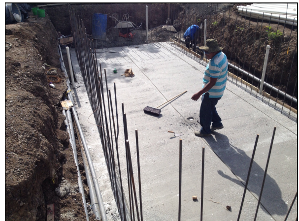
Fig. 54 Finalización de la losa
