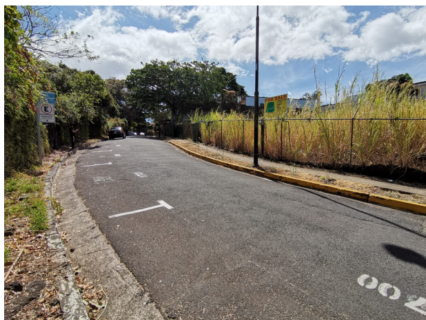
Imagen 6.3 Fotografía estado actual del lote. Fuente: Elaboración propia.
