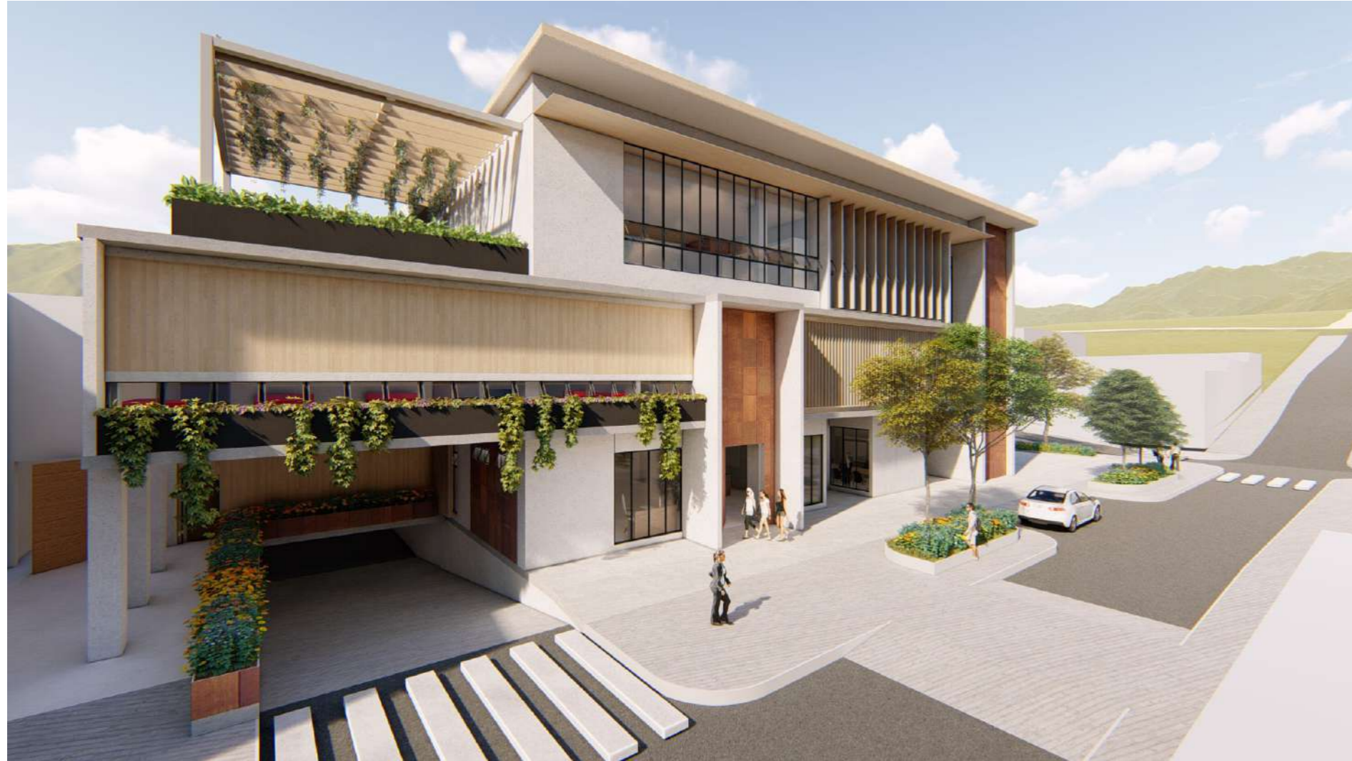
Imagen C4.35 Fachada sur. Fuente: Propia.
