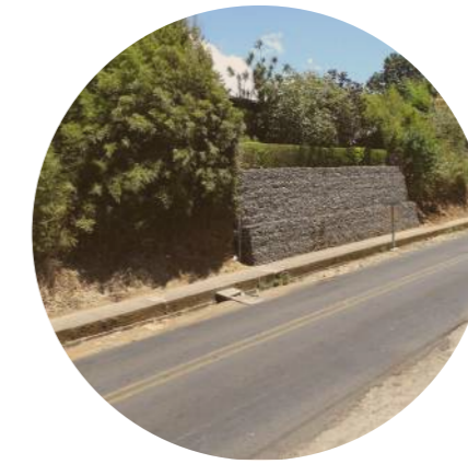
2 Imagen C2.2 Parada autobuses, Av. 2. Fuente: Levantamiento de sitio, 2020. Autoría: Propia.
