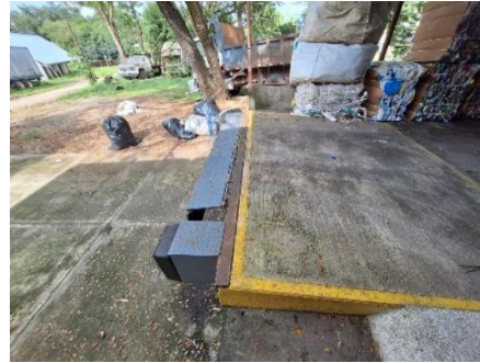
Figura 4.51: Rampa niveladora del CRRV de Nicoya.
