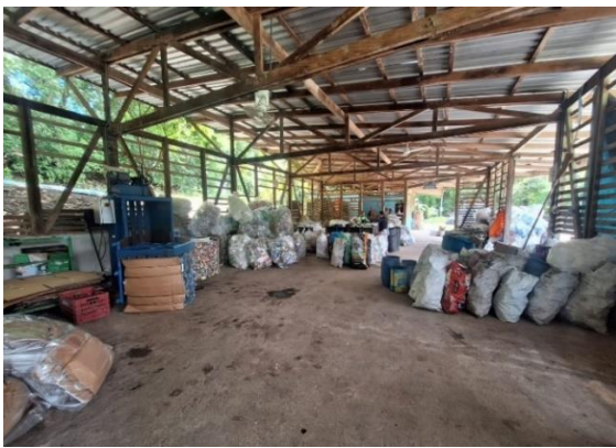
Figura 4.1: Infraestructura del CRRV de Nosara Recicla.
