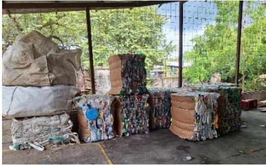
Figura 4.50: Paredes del CRRV de Nicoya.
