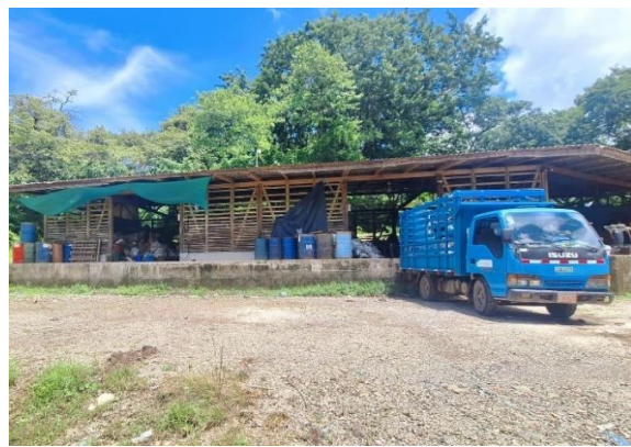
Figura 4.2: Zona de parqueo del CRRV de Nosara Recicla.
