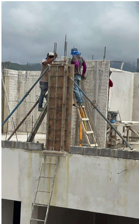
Figura 29. Fotografía de encofrado de columnas para Crew Balance.
