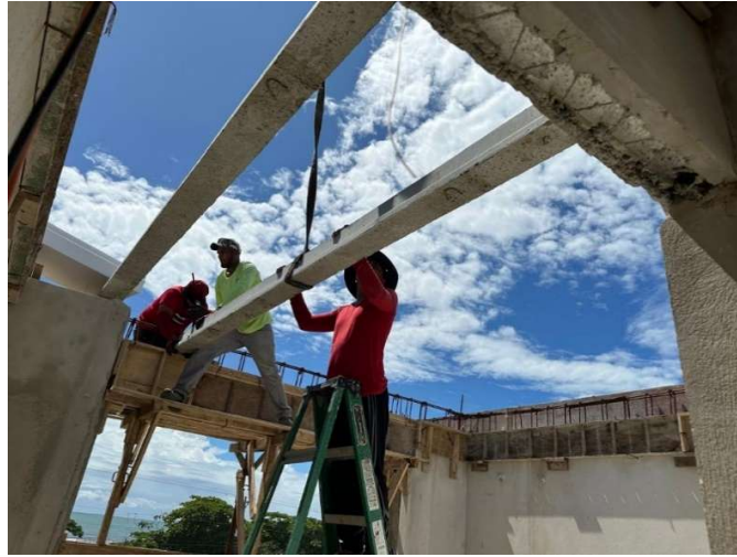
Figura 49. Fotografía de la colocación del entrepiso de viguetas pretensadas.
