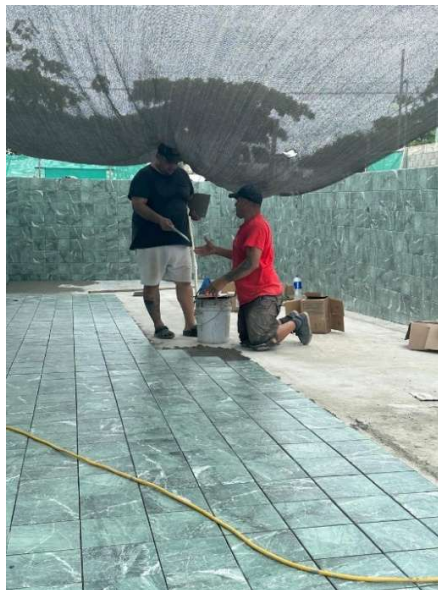
Figura 33. Fotografía de colocación de cerámica para Crew Balance y Five Minutes Rating.
