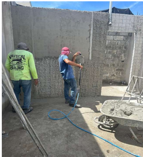
Figura 41. Fotografía de repello de paredes para Crew Balance.
