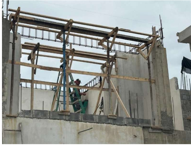
Figura 32. Fotografía de colocación de formaleta para Crew Balance.
