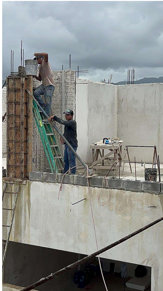
Figura 31. Fotografía de colado de columnas para Five Minutes Rating.
