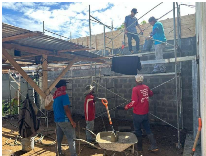
Figura 43. Fotografía de colado de viga para Work Sampling.
