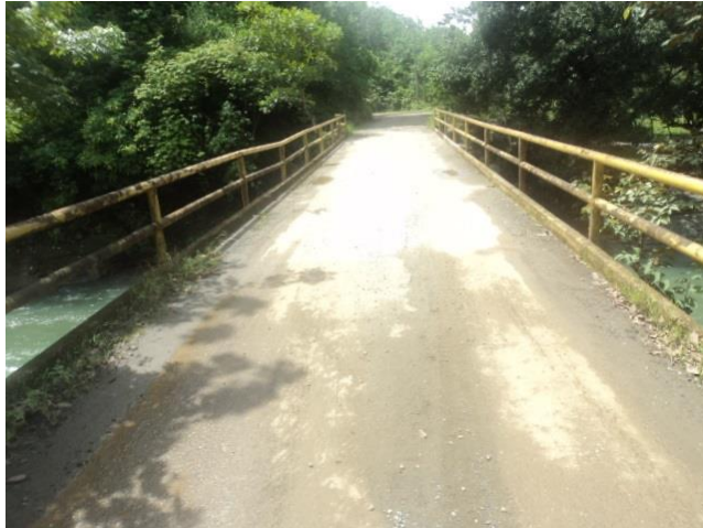
Figura 39: Vista panorámica del puente sobre el río Guineal
