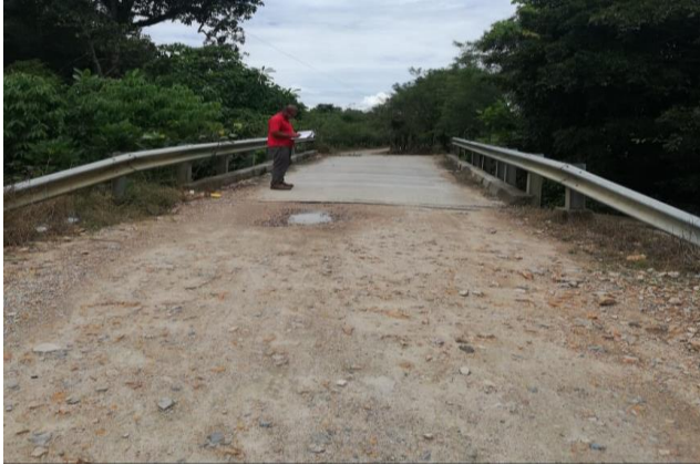
Figura 55: Vista panorámica del puente sobre la quebrada Kori
