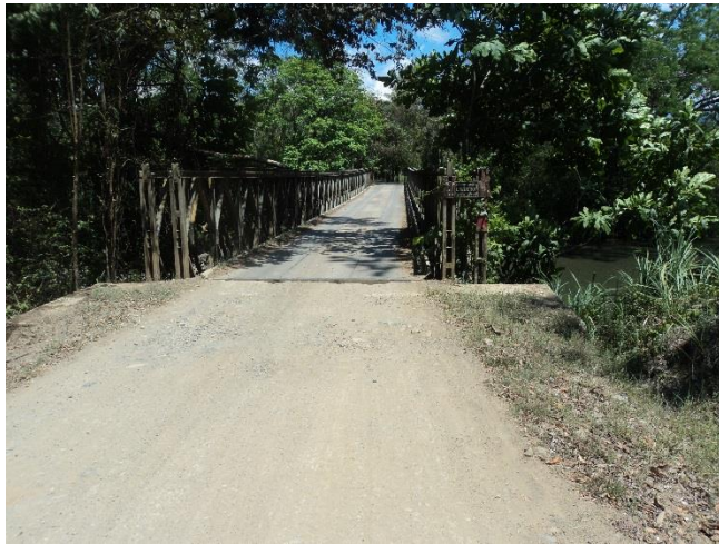
Figura 90: Vista panorámica del puente sobre el río Limón
