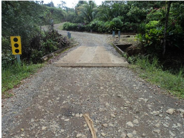
Figura 80: Vista panorámica del puente sobre la quebrada Cordoncillo.
