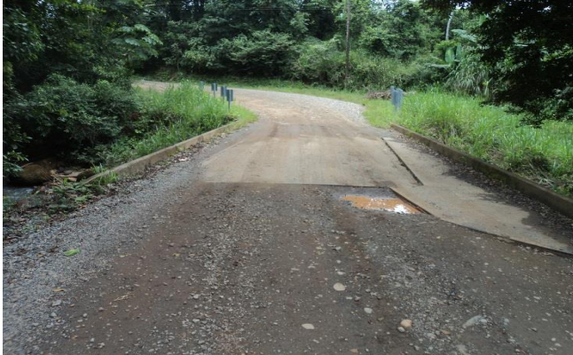
Figura 67: Vista panorámica del puente sobre la quebrada Guapinola. Fuente Autor
