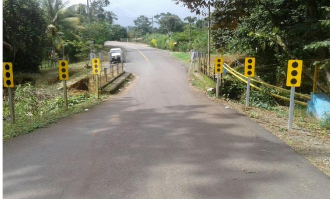
Figura 73: Vista panorámica del puente sobre la quebrada Peje.
