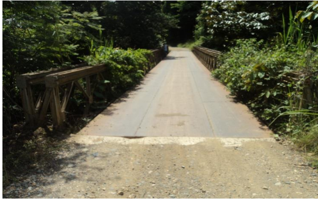
Figura 43: Vista panorámica del puente sobre el río Brujo
