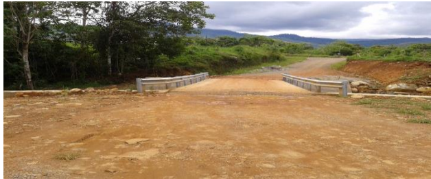
Figura 77: Vista panorámica del puente sobre la quebrada Seca.
