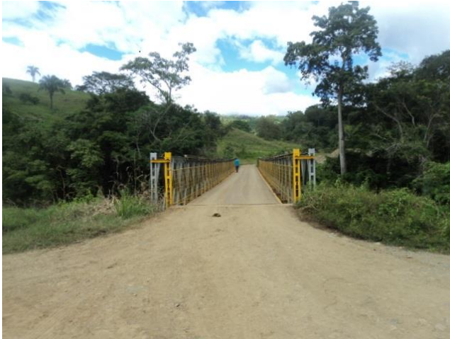
Figura 85: Vista panorámica del puente sobre el río Pilas
