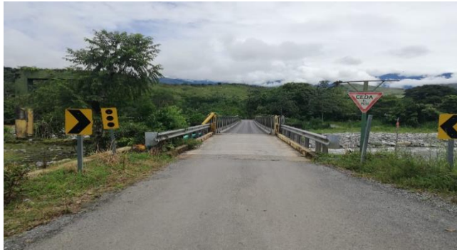
Figura 49: Vista panorámica del puente sobre el río Ceibo
