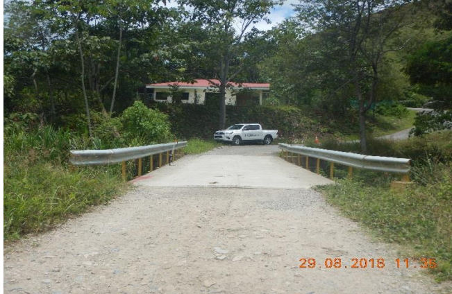
Figura 63: Vista panorámica del puente sobre la quebrada Ditsirí
