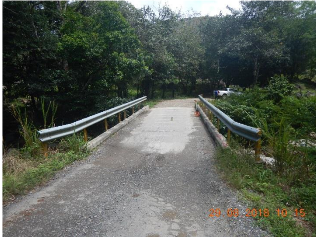
Figura 59: Vista panorámica del puente sobre la quebrada Skra
