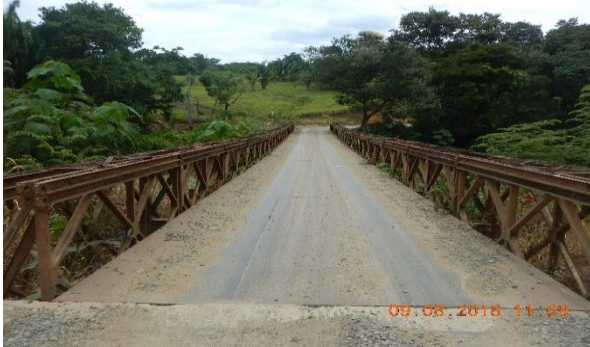
Figura 27: Vista panorámica del puente sobre el río Sábalo
