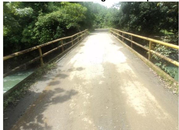
Figura 42: El puente en términos generales está en buena condición.
