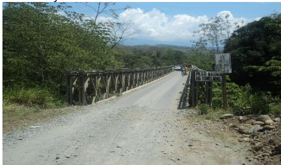
Figura 22: Vista panorámica del puente sobre el río Coto Brus (Bajo Coto)
