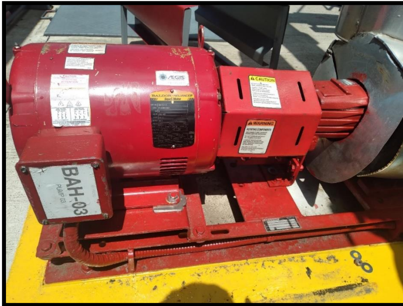
Figura 58. Bomba Bell & Gossett de tipo e-1510 SSF 5.375
