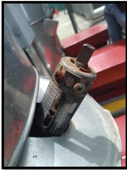
Figura 60. Válvula de triple servicio Bell & Gossett
