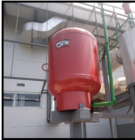
Figura 70. Bell & Gossett Series B-200LA ASME Pressurized Expansion Tank serie N.O 344005
