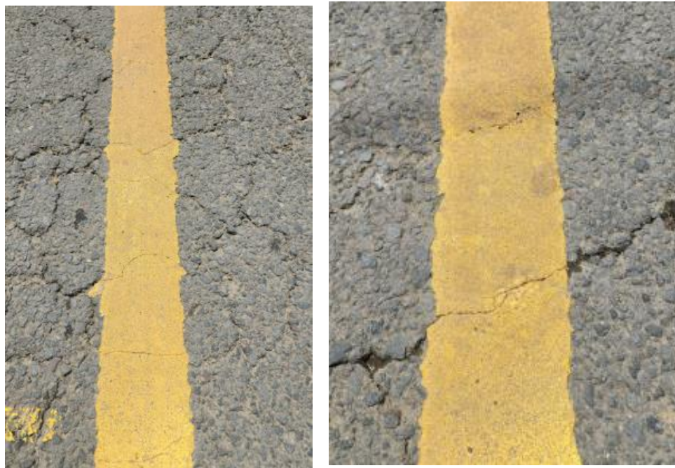
Figura 133 Pintura base solvente adaptada a las fisuras de la calzada.
