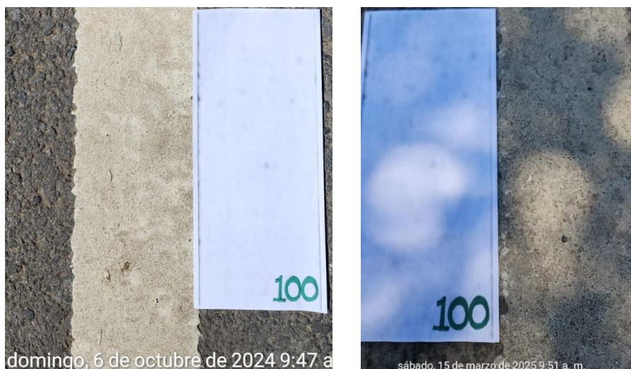
Figura 117 Desprendimiento material termoplástico, el día 6/10/2024
