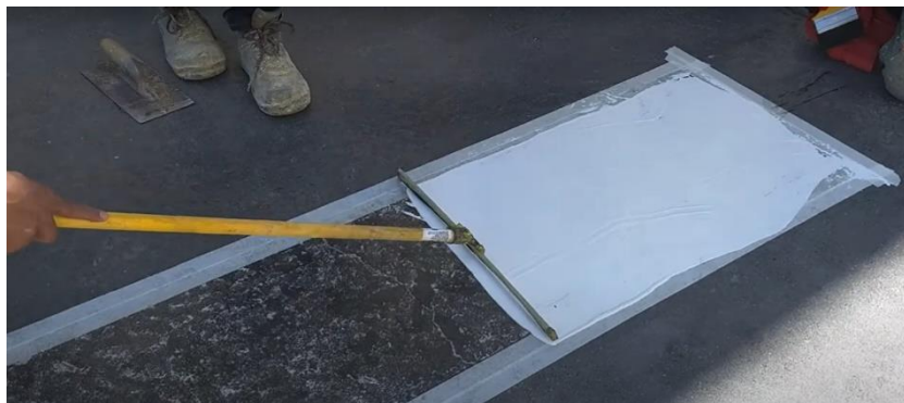
Figura 6 Demarcación de pintura plástico en frío con llaneta Fuente: Fuente: página oficial de la empresa Pintraf
