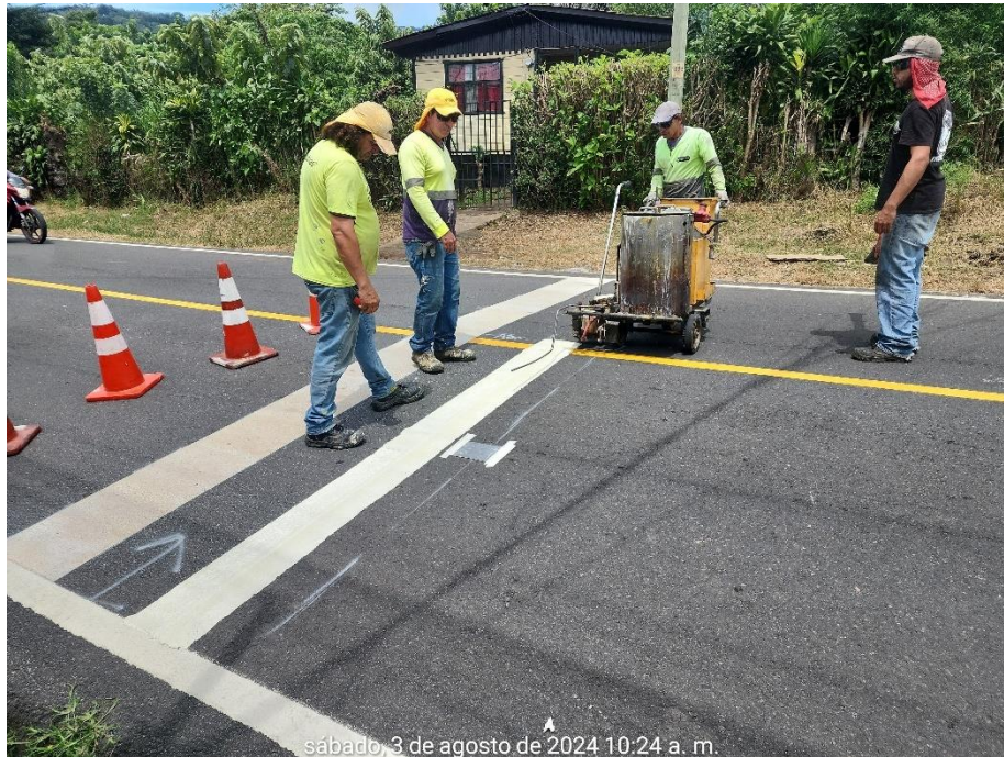
Figura 24 Demarcación de líneas transversales con material termoplástico
