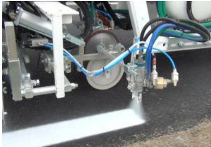
Figura 2 Aplicación de pintura plástica en frío con técnica de pulverización
