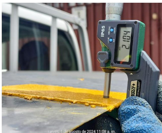
Figura 38 Medición de espesor de material termoplástico el 01 de agosto, 2024 Barrio María Auxiliadora.
