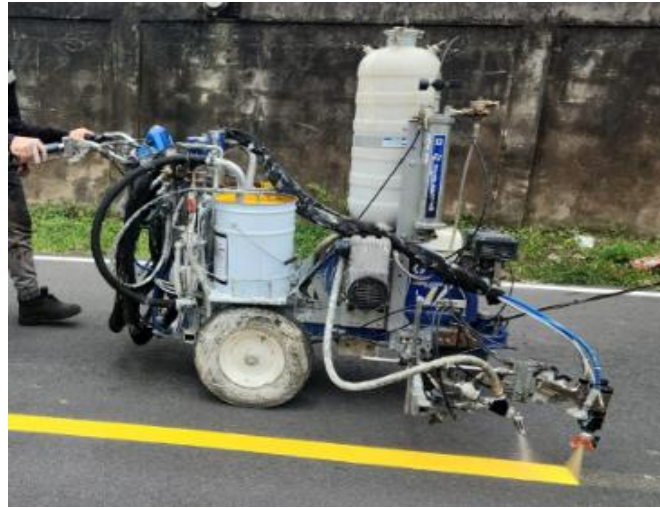
Figura 22 Equipo de demarcación para pintura plástico en frío
