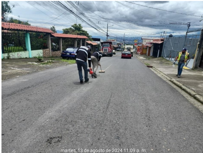
Figura 18 Preparación de la Superficie, limpieza
