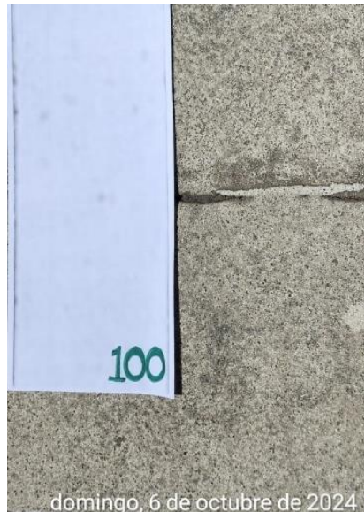
Figura 105 Desprendimiento material termoplástico, el día 6/10/2024
