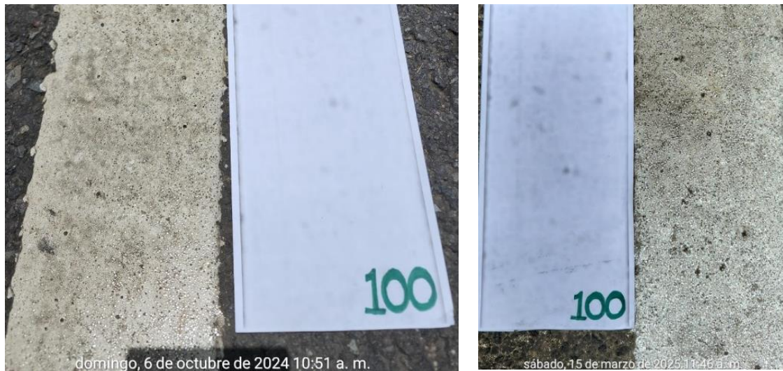
Figura 79 Desprendimiento material termoplástico, el día 6/10/2024
