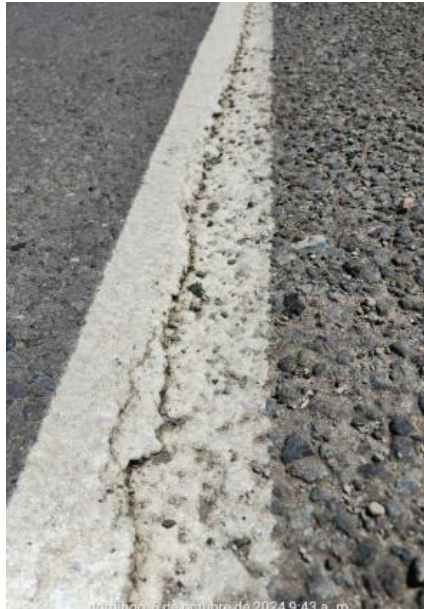
Figura 131 Pintura plástico en frío adaptada a la irregularidad de la calzada
