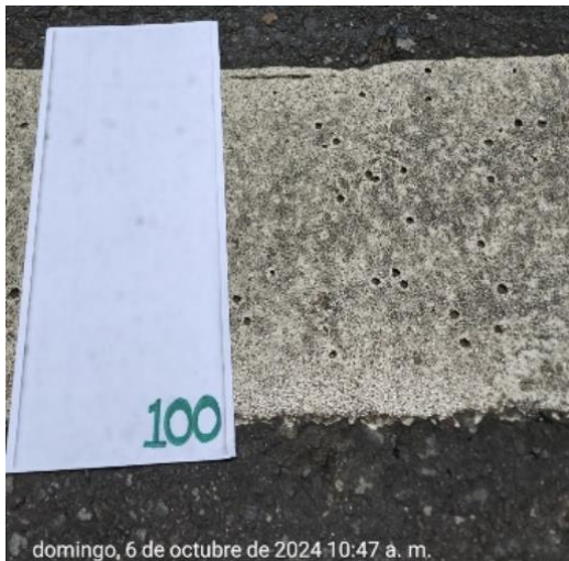
Figura 67 Desprendimiento de material termoplástico, el día 6/10/2024
