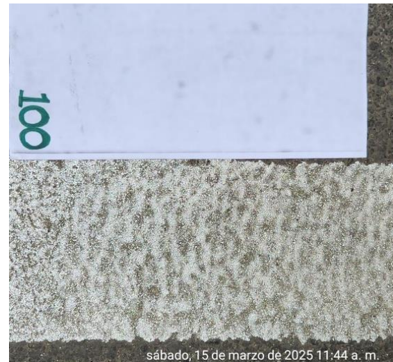
Figura 75 Desprendimiento pintura plástico en frío, el día 6/10/2024
