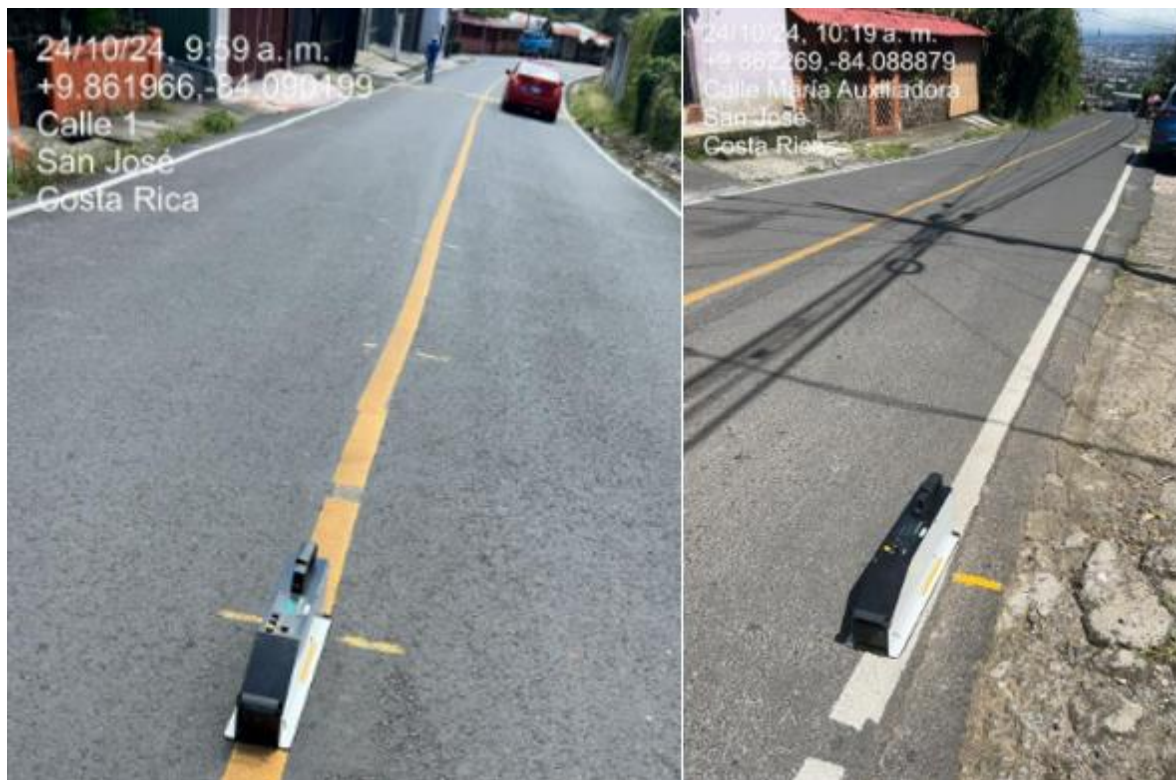
Figura 29 Medición de retroreflectividad del 24 de octubre del 2024, en paños de prueba varios
