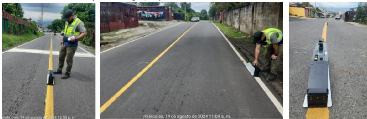
Figura 27 Medición de retroreflectividad el 14 de agosto del 2025, Paños de prueba varios
