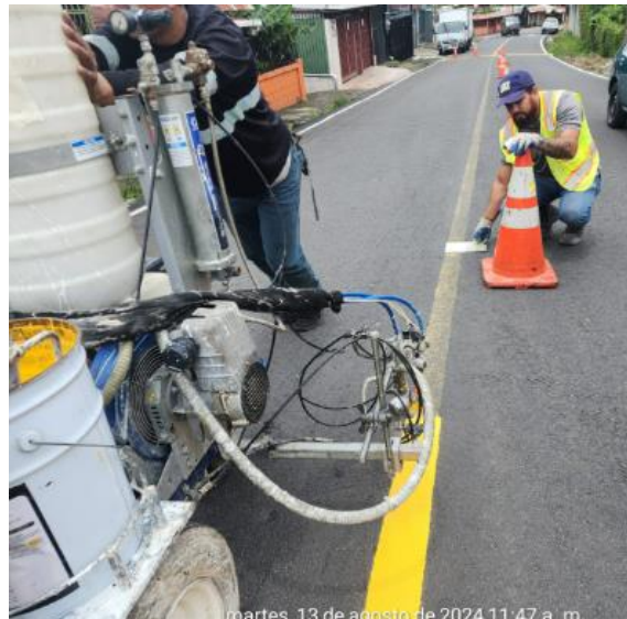
Figura 41 Medición de espesor de pintura plástico en frío el 13 de agosto, 2024 Barrio María Auxiliadora.
