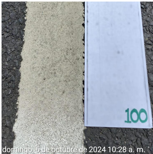
Figura 98 Desprendimiento material termoplástico, el día 6/10/2024
