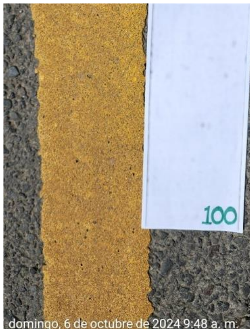
Figura 111 Desprendimiento material termoplástico, el día 6/10/2024
