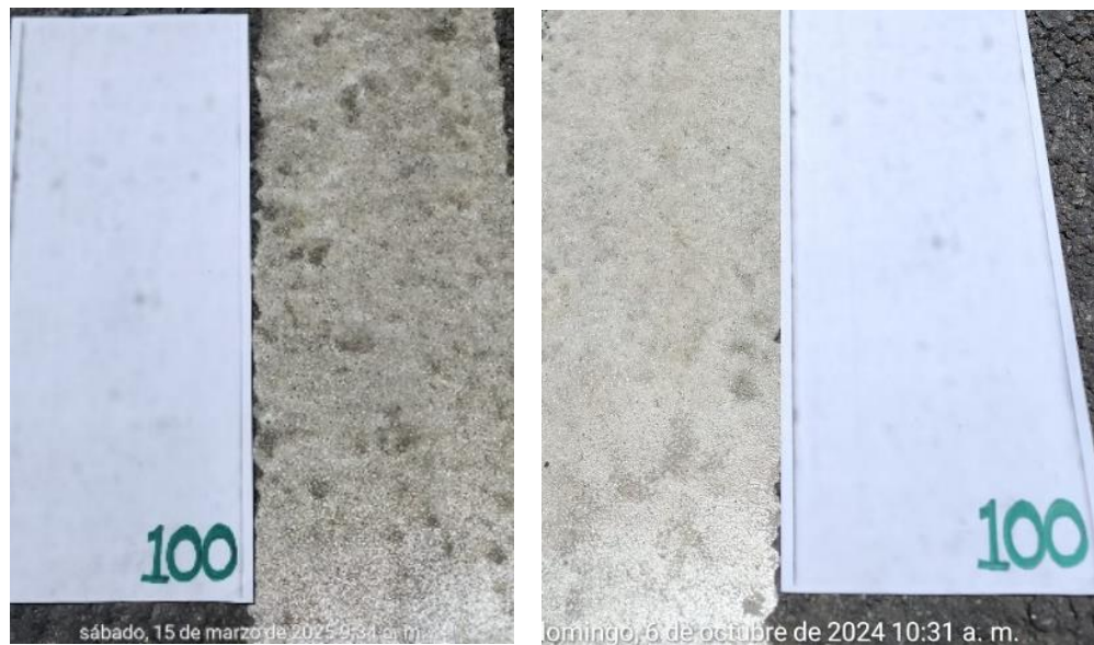
Figura 94 Desprendimiento pintura plástico en frío, el día 6/10/2024
