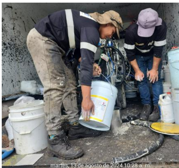
Figura 44 Muestreo de componentes de pintura plástico en frío
