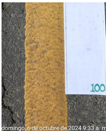
Figura 107 Desprendimiento pintura plástico en frío, el día 6/10/2024
