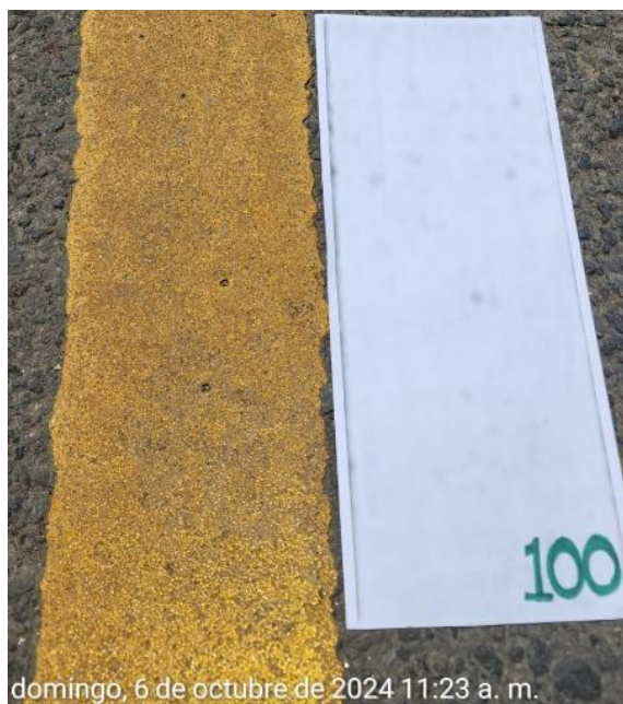
Figura 123 Desprendimiento material termoplástico, el día 6/10/2024
