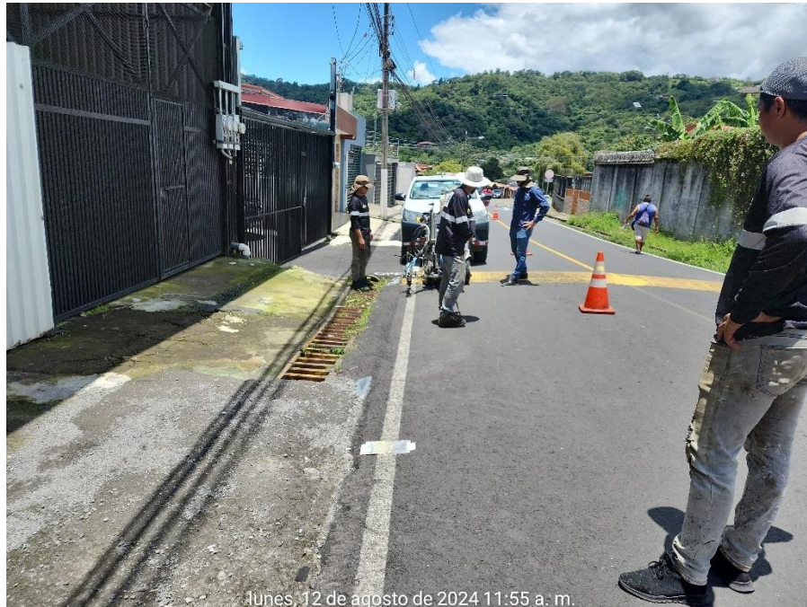
Figura 26 Demarcación de línea borde con pintura plástico en frío
