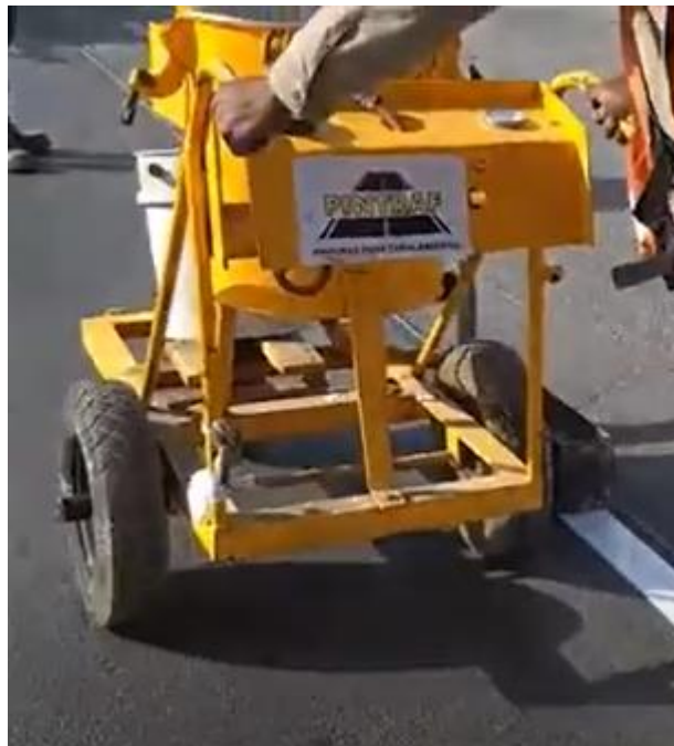
Figura 5 Demarcación por extrusión de pintura plástico en frío Fuente: página oficial de la empresa Pintraf
