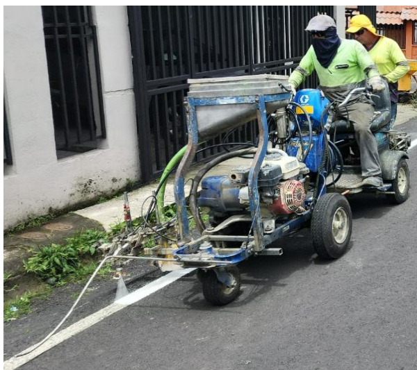
Figura 20 Equipo de demarcación de pintura base solvente
