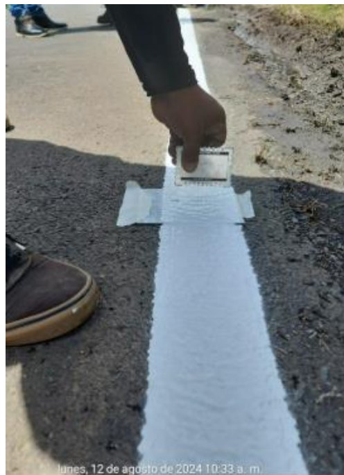
Figura 40 Medición de espesor de pintura plástico en frio el 12 de agosto, 2024 Barrio María Auxiliadora.
