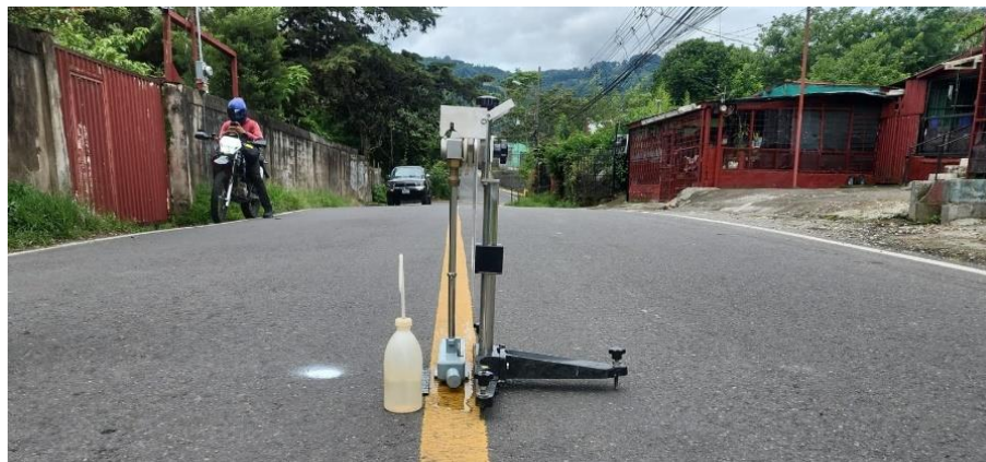
Figura 140 Medición de la resistencia al deslizamiento con péndulo británico. Barrio San Francisco Plástico en Frio
