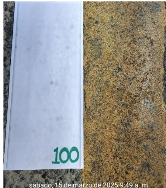
Figura 111 Desprendimiento material termoplástico, el día 6/10/2024
