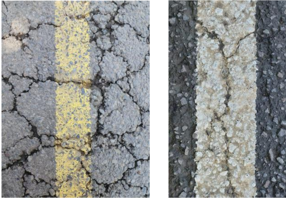
Figura 133 Pintura base solvente adaptada a las fisuras de la calzada.
