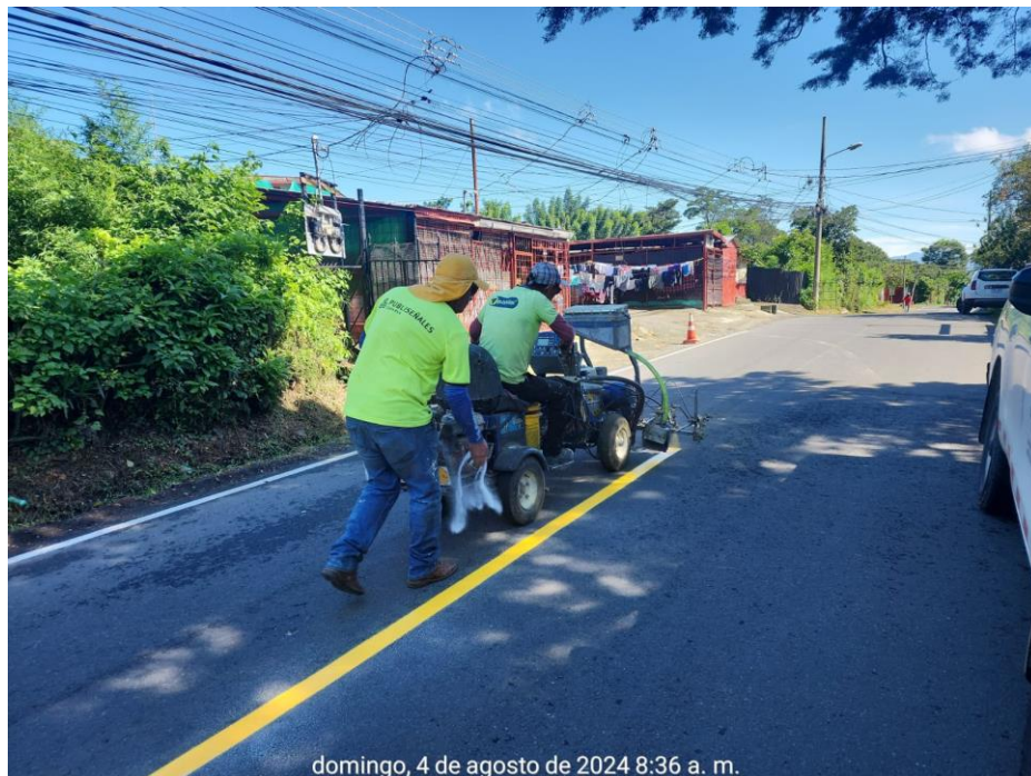
Figura 25 Demarcación de línea amarilla con pintura base solvente
