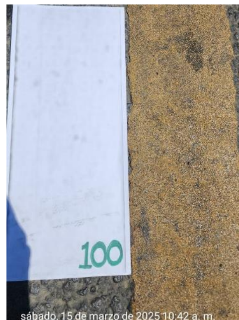
Figura 123 Desprendimiento material termoplástico, el día 6/10/2024
