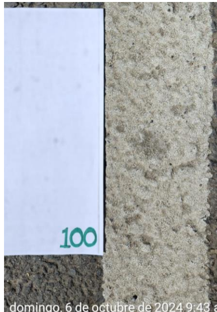
Figura 113 Desprendimiento pintura plástico en frío, el día 6/10/2024
