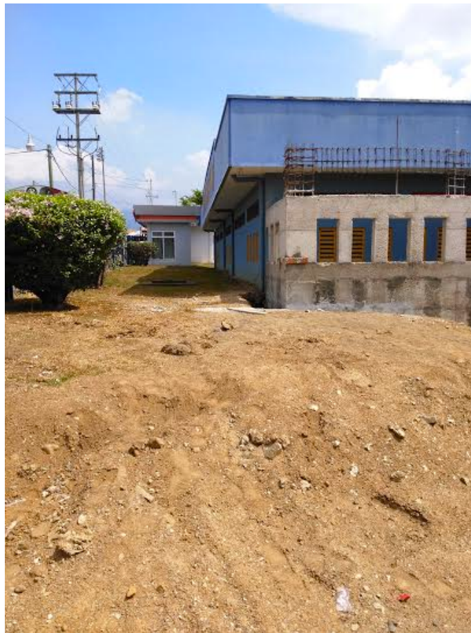
Figura 20. Ampliación del cuarto de subestación.
