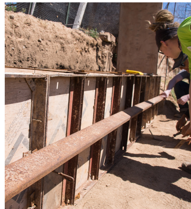
Imagen 30. Encofrado para construcción en tapial. Fuente: propia.
