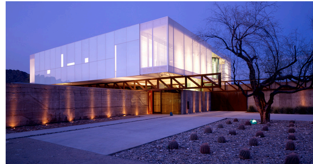
Imagen 46. Uso del tapial como cerramiento en primer nivel. Fuente: Jones Studio.
