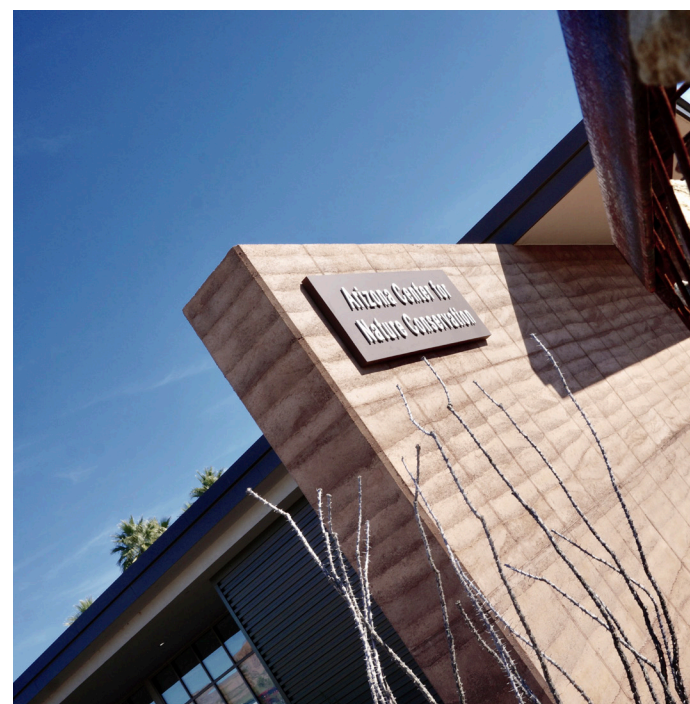
Imagen 2. Phoenix Zoo, muro en tapial. Fuente: propia.
