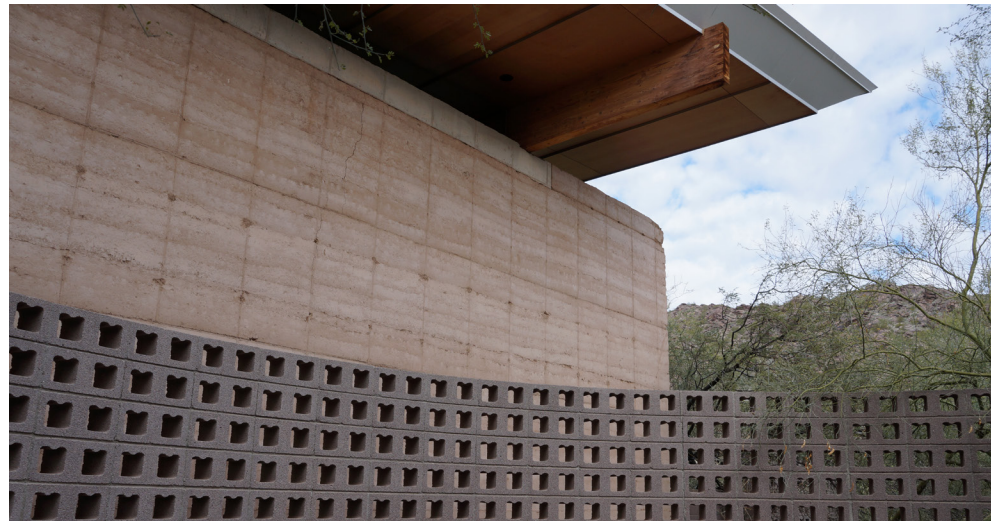
Imagen 45. Extensión de aleros y base en concreto para protección de muros en tierra. Fuente: propia.
