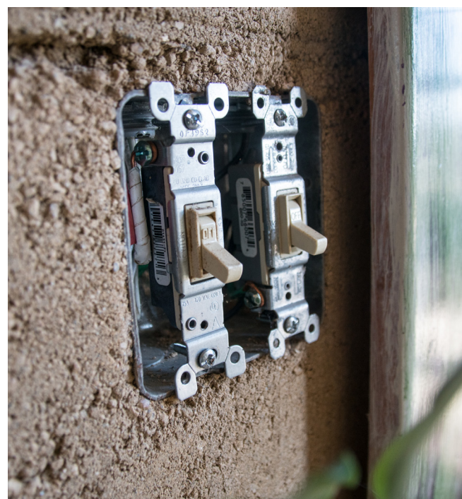
Imagen 17. Instalación eléctrica en muros de tapia. Fuente: propia.
