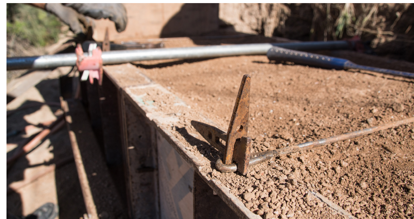
Imagen 18. Muro de tapial compactado. Fuente: propia.
