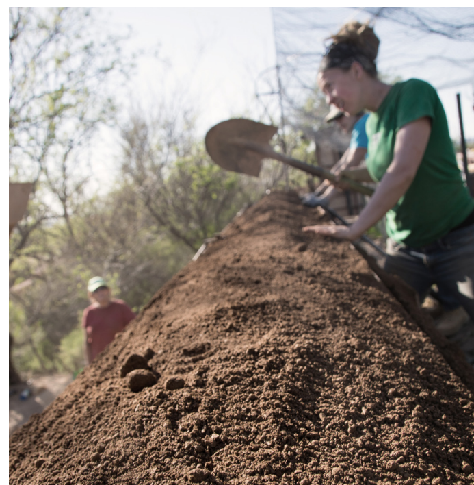
Imagen 12. Vertido de tierra encontrado. Fuente: propia.
