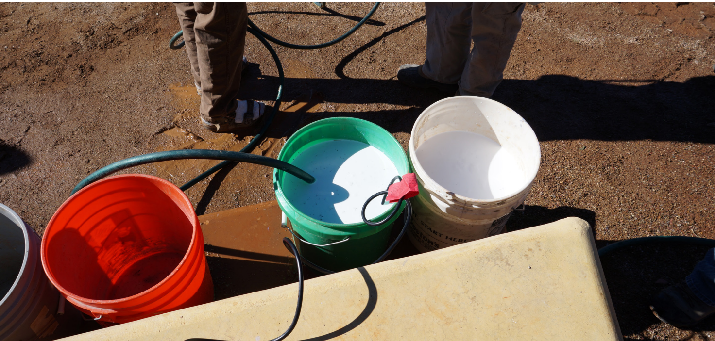
Imagen 27. Mezcla de aglomerante con el agua. Fuente: propia.
