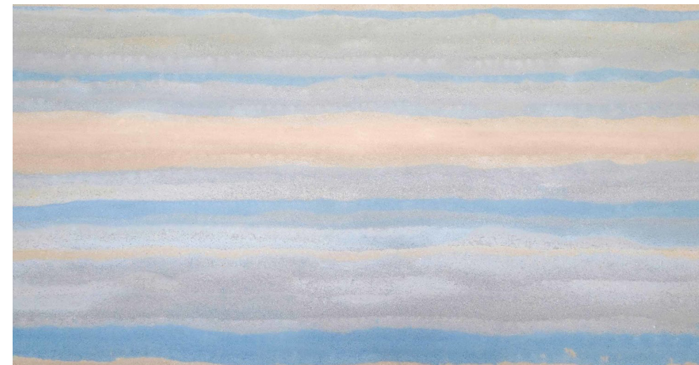
Imagen 48. Muro en tapial con diferentes tonalidades. Fuente: Rammed Earth Works.
