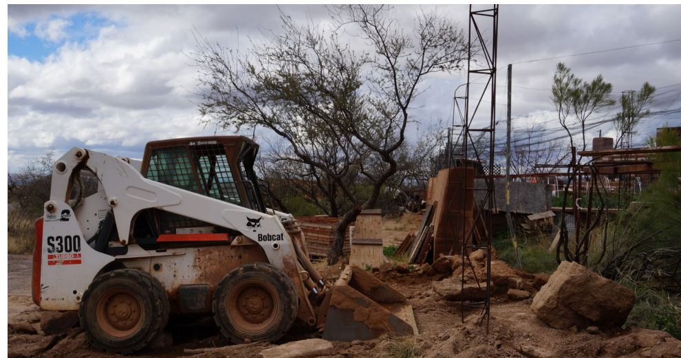
Imagen 47. Demolición de muro en tierra. Fuente: propia.
