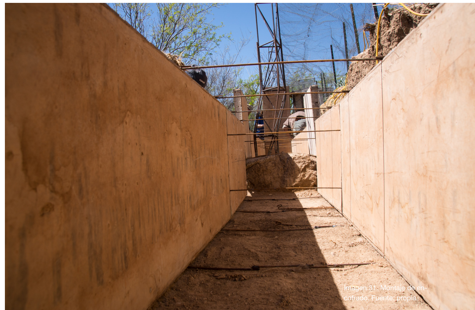
Imagen 30. Encofrado para construcción en tapial. Fuente: propia.
