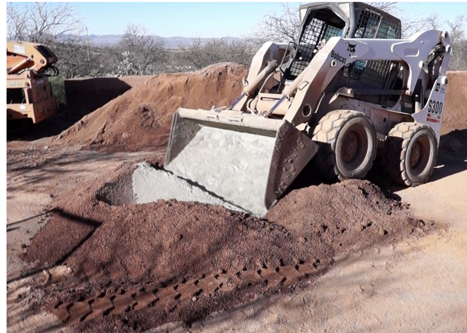
Imagen 26. Mezclado de la tierra con cemento. Fuente: propia.
