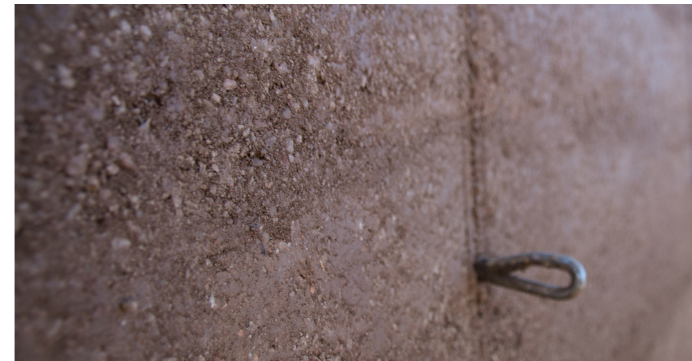
Imagen 44. Impermeabilización de muro durante la mezcla. Fuente: propia.
