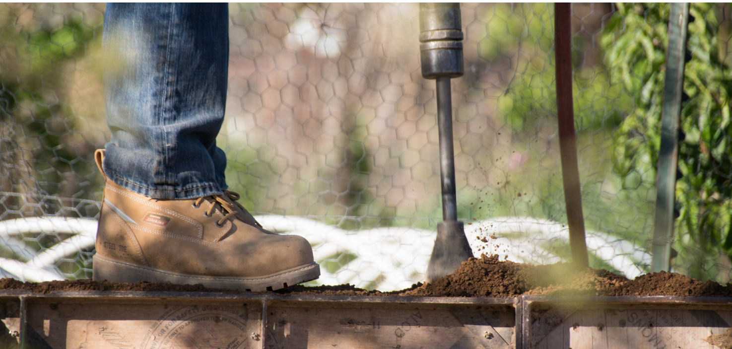
Imagen 32. Apisonado de tongada de tierra en el encofrado. Fuente: propia.
