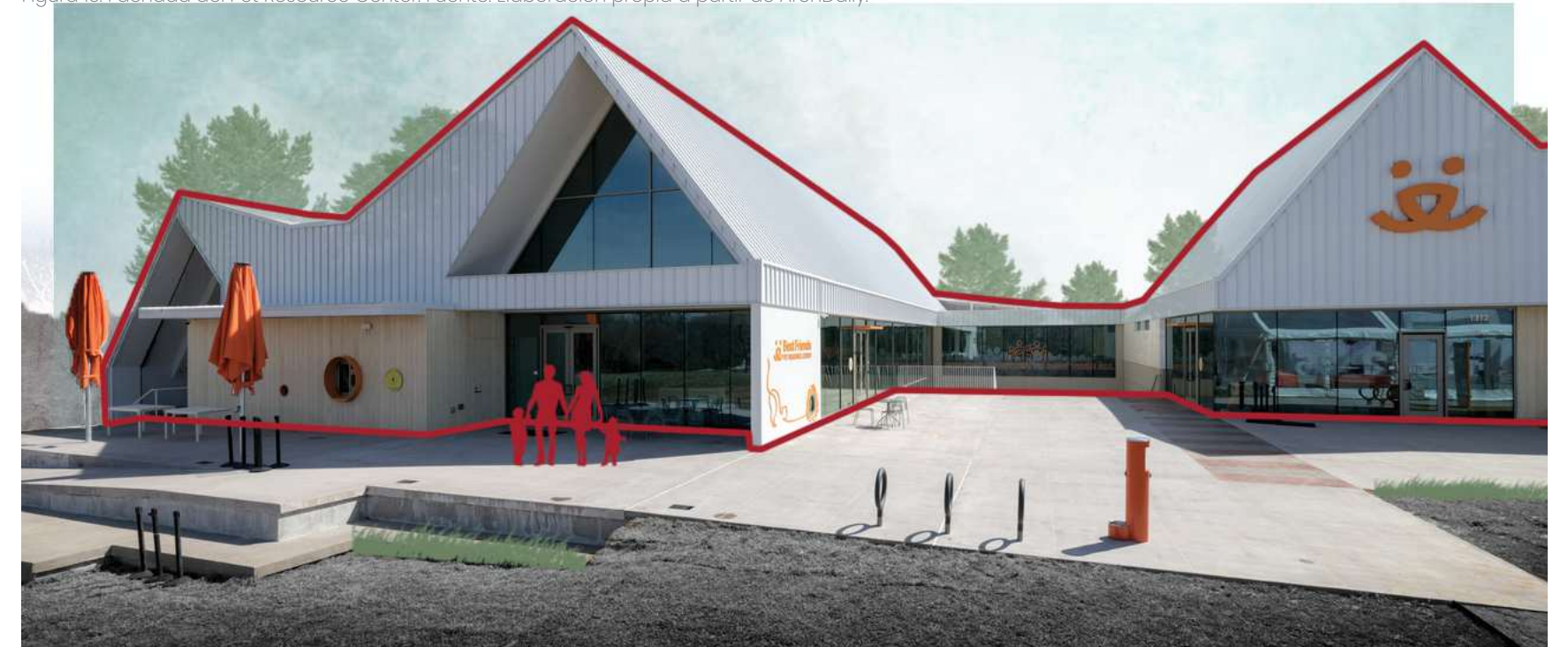
Figura 13. Fachada del Pet Resource Center. Fuente: Elaboración propia a partir de ArchDaily.
