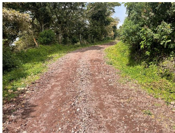
Figura 21. Roderas y agregado suelto UM-02 Jaules 20/09
