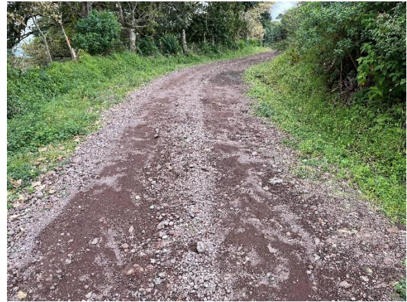
Figura 40. Roderas y agregado suelto UM-02 Jaules 18/10
