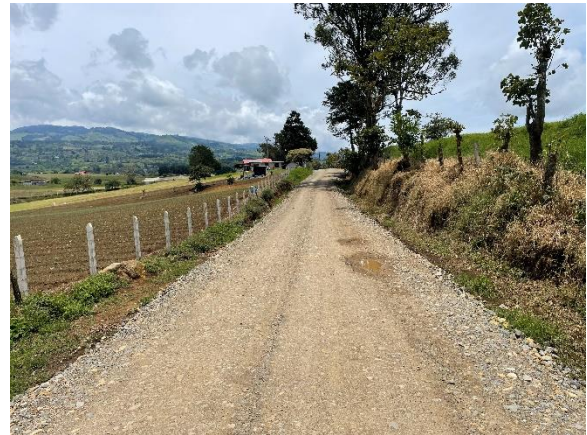
Figura 15. Sección transversal inadecuada UM-03 El Cerro 20/09
