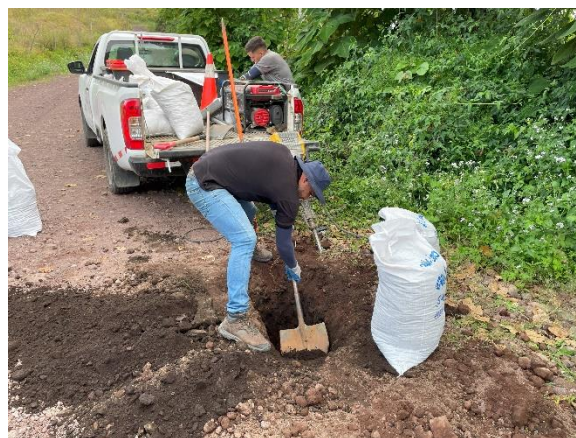
Figura 22. Sondeo a cielo abierto Jaules 02/10
