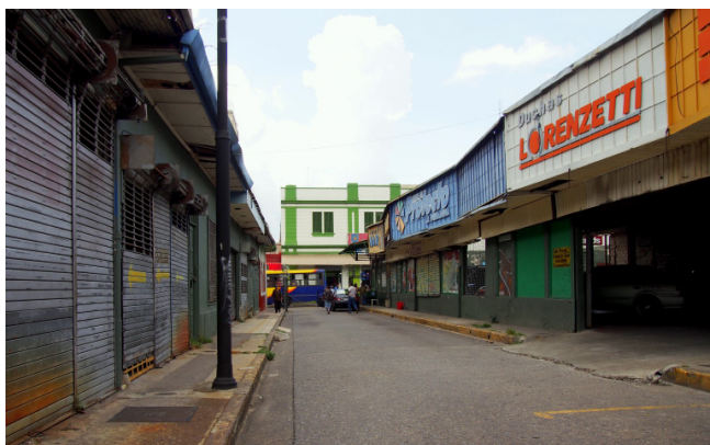
Imagen 60 Estado actual del Pasaje Jiménez. Fotografías de Emmanuel Salazar.
