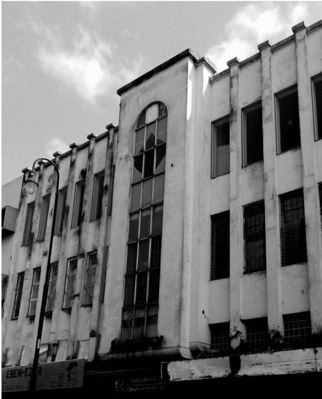
Imagen 47 Estado general de la infraestructura. Fotografía tomada por Enmanuel Salazar Ceciliano.
