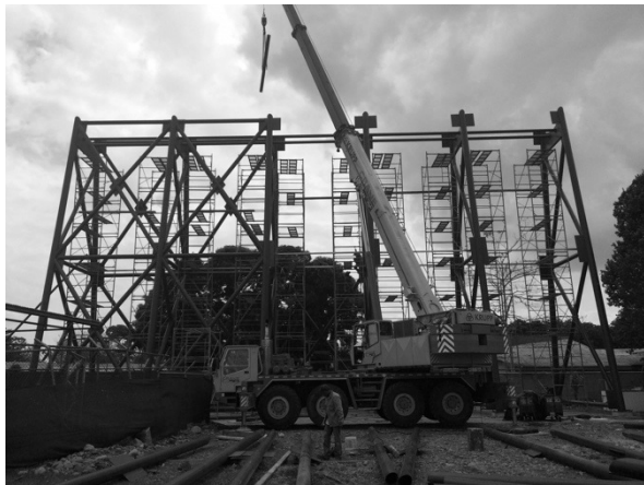
Figura 37. Ensamblaje de arriostres Fuente: elaboración propia
