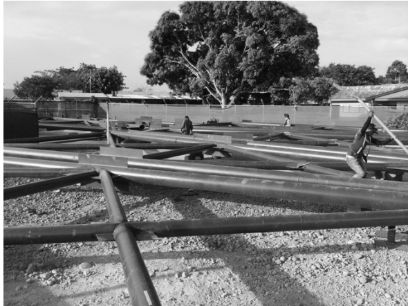
Figura 36. Ensamblaje de marcos Fuente: elaboración propia
