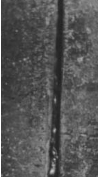
(b) Junta con falta de penetración
