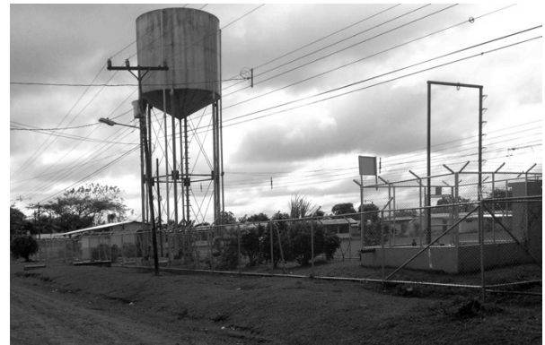
Figura 1. Estado actual del sistema de abastecimiento de agua potable en la comunidad de Los Chiles Fuente: elaboración propia
