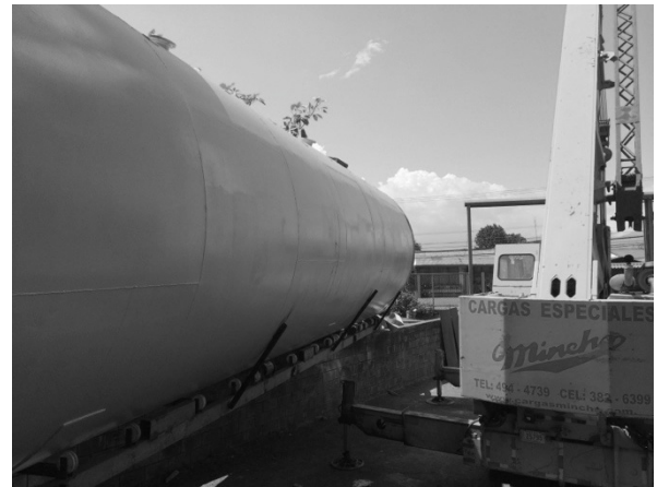
Figura 27. Proceso de carga de la sección 1 del cilindro Fuente: elaboración propia
