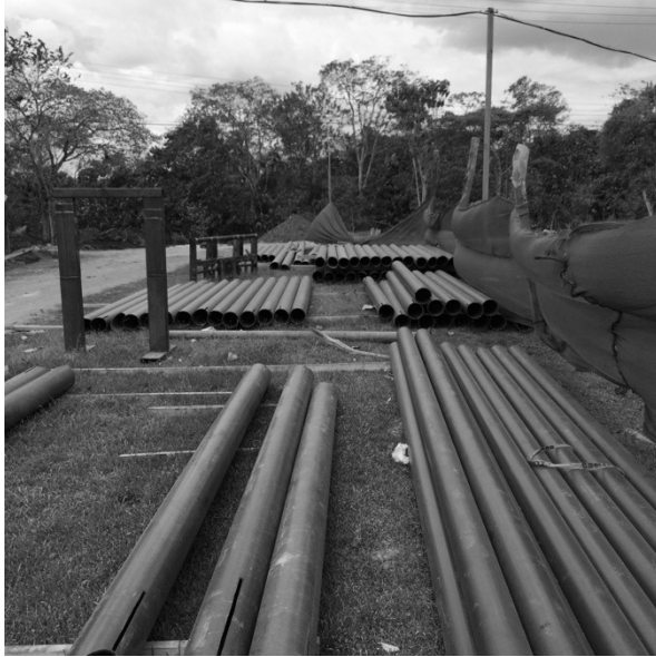
Figura 29. Apilamientos de tubería en el sitio de ensamblaje Fuente: elaboración propia
