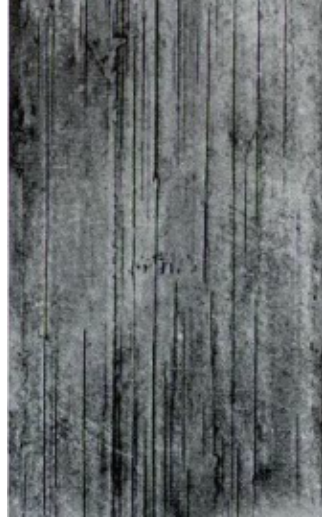
(c) Grietas producto de costuras
