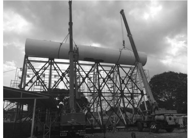
Figura 38. Izaje del cilindro Fuente: elaboración propia
