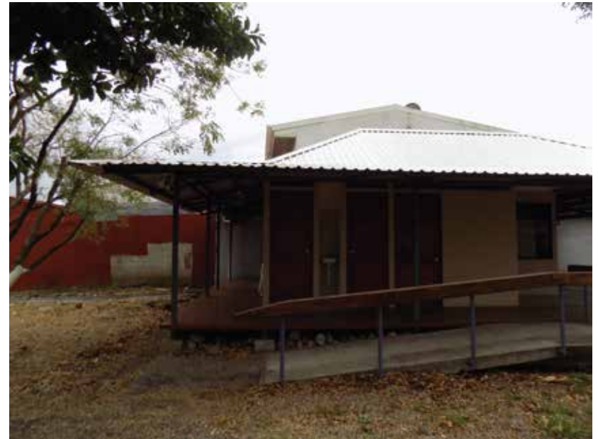
Imagen 75. Batería baños y oficina seguridad , fuente propia
