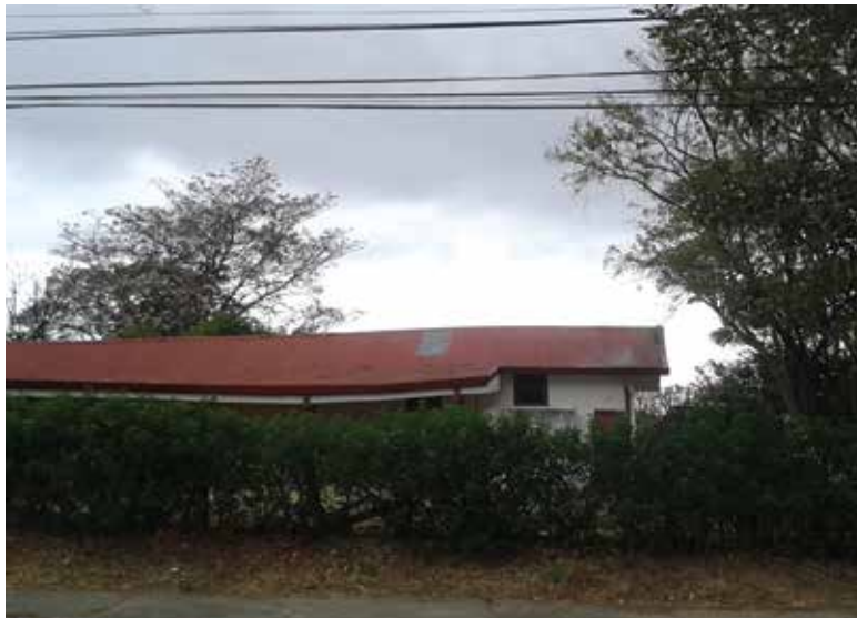
Imagen 65. Techo casa bahareque. Fuente propia
