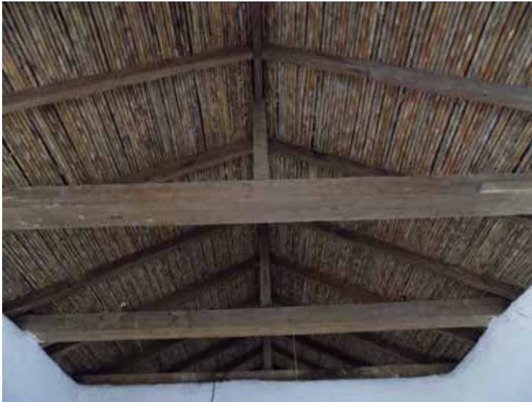
Imagen 60. Detalle estructura techo casa La Calera. Fuente propia
