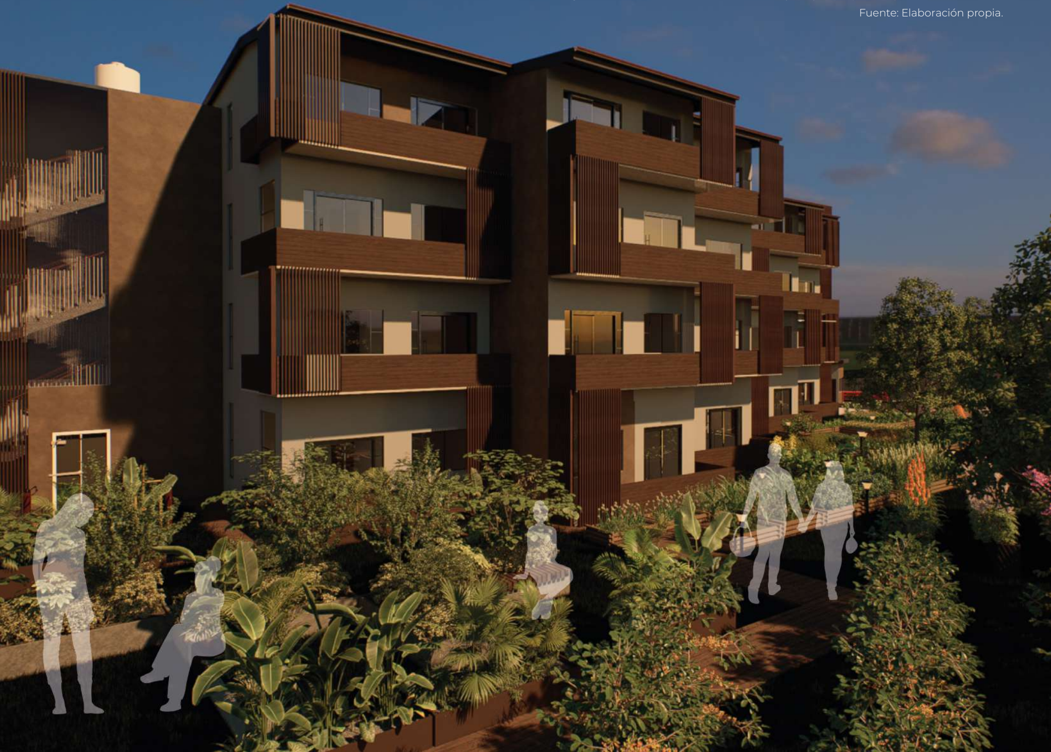
Figura 180: Visualización de fachada oeste y sur y su respectiva protección climática.
