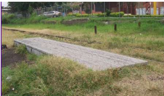
Figura 75: Estación de tren PECOSA.
