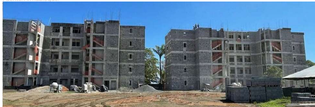
Figura 176: Vistas de Bejuco, Puntarenas. Proyecto residencial construido con sistema de mampostería integral.
