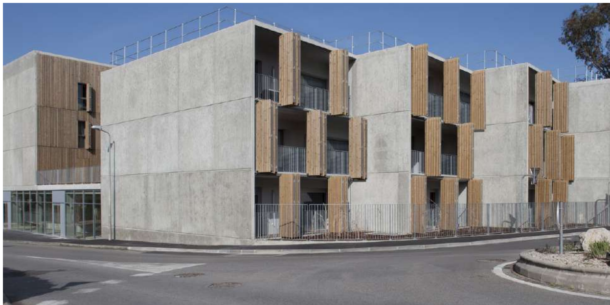
Figura 22: Vivienda social colectiva en Francia. Fuente: Plataforma Arquitectura.
