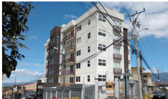
Figura 82: Edificio de 5 niveles.
