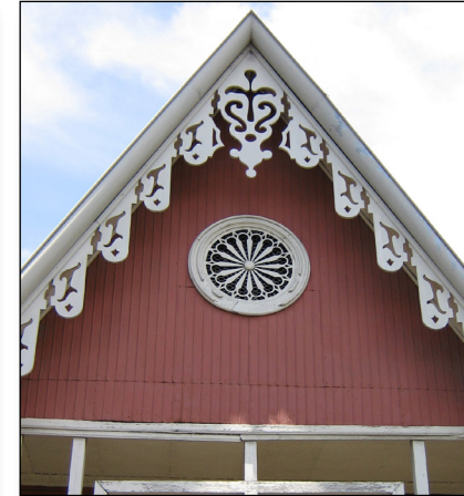
Filigranas y roseta que permite ventilación en cielos internos.
