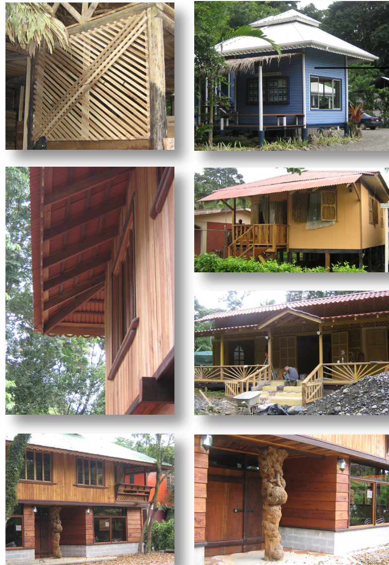
Fig. 7.25 Imágenes de la multiplicidad del uso de la madera en las viviendas de Puerto Viejo.
