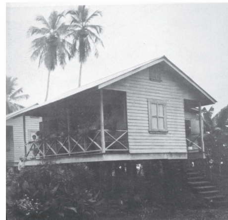
Estas viviendas, eran nuevos campamentos, como una mejora sobre tipos más viejos que se usaban como alojamientos generales de las cuadrillas.
