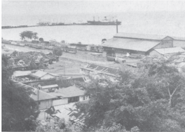
Las fincas más grandes de cacao, enviaban sus granos mojados a la planta secadora mecánica en Limón. La planta es el edificio grande en el centro derecho de la imagen.
