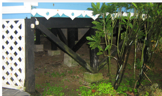
Fig. 7.11 Viviendas elevadas sobre pilotes.
