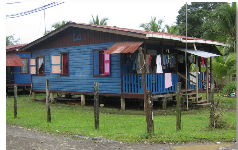
Fig. 1.4 Detalle del mal estado de conservación, de las viviendas victorianas caribeñas en Puerto Viejo.
