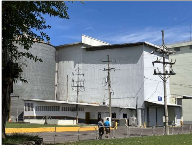
Figura 14. Distribución de postes para el cableado interno de FHACASA.
