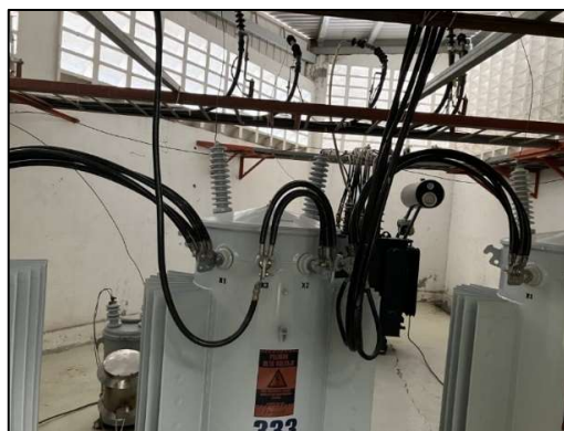
Figura 15. Banco de transformadores monofásicos tipo poste.
