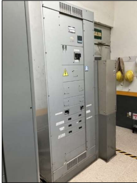
Figura 16. Tablero tipo P5 del cuarto eléctrico y sus cargas.
