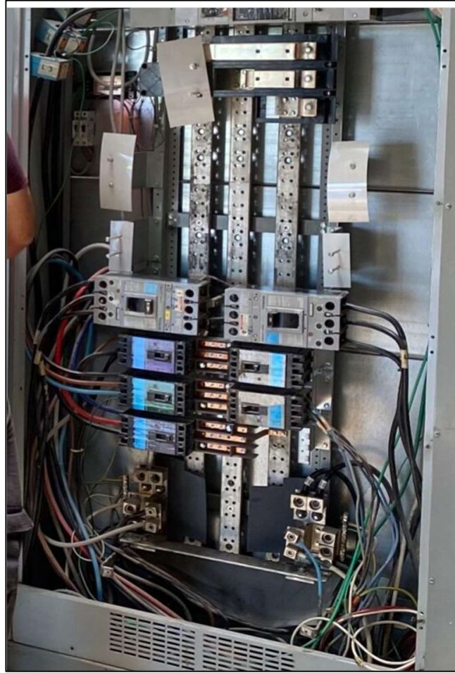
Figura 22. Estado de cableado interno y barras del tablero tipo P5.
