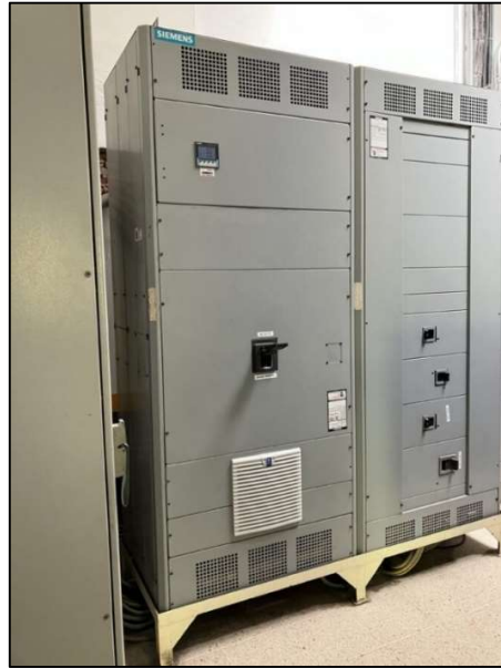
Figura 17. Tablero tipo Switchboard del cuarto eléctrico y sus cargas.
