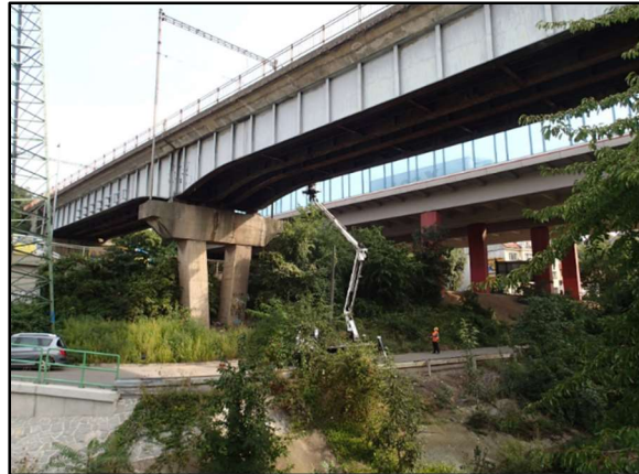
Figura 2. Vista longitudinal del puente.
