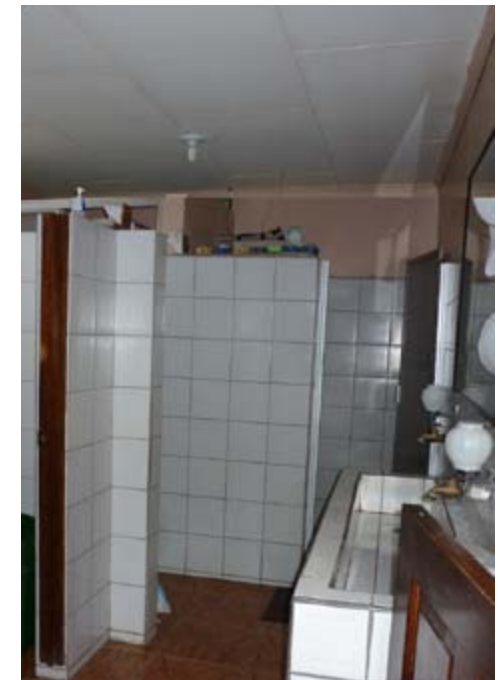
Imagen 51. Fotografía de servicios sanitarios de casa tipo. Fuente: propia.
