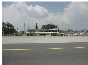
Terminal desde pista
