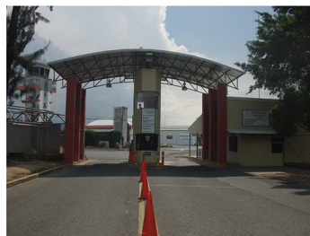
Acceso a hangares
