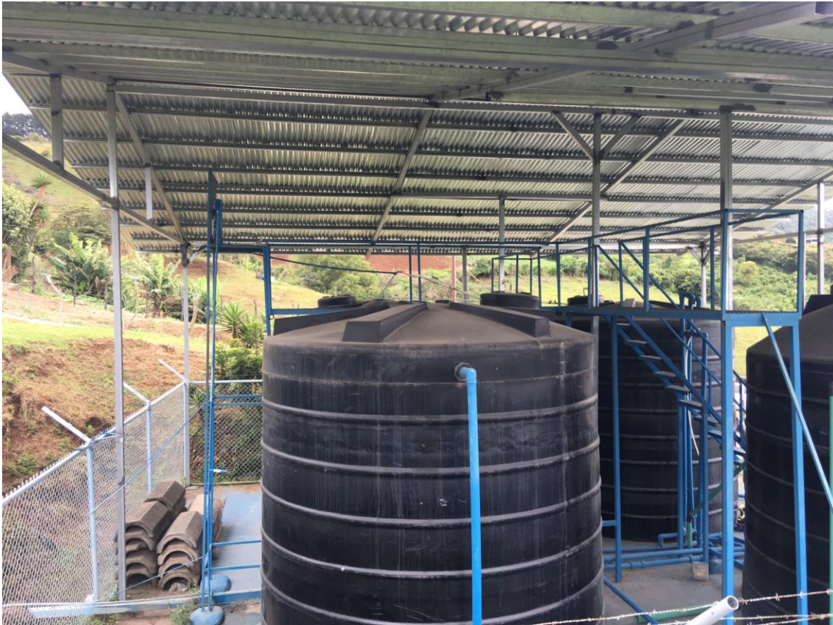
Figura A.1.8 Tanques de almacenamiento, estructura metálica sobre la que estaba instalado el clorador artesanal de cámara seca y sus tuberías de distribución entre 3/4 tanques
