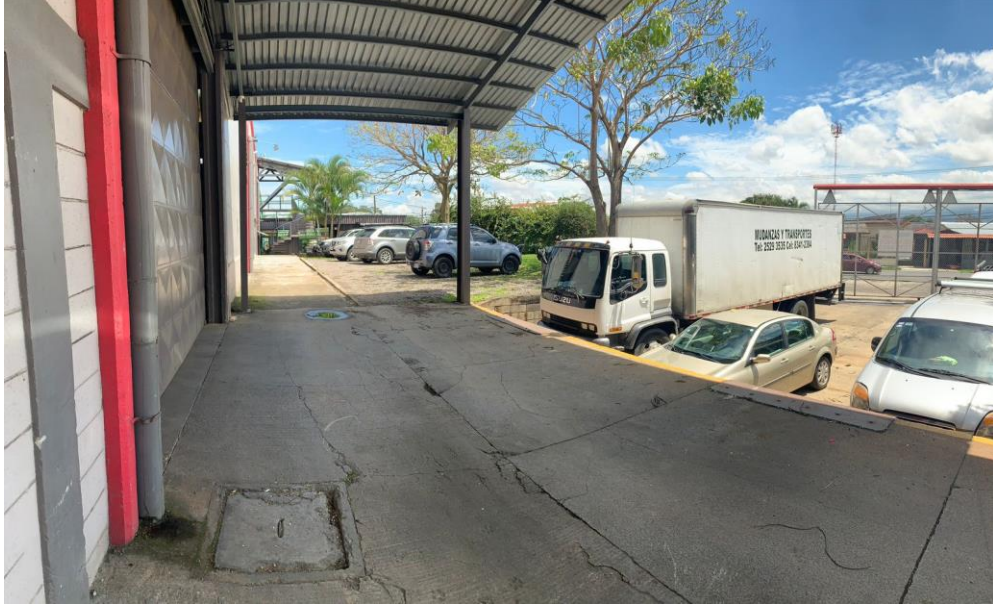
Figura 12. Zona de carga y descarga
