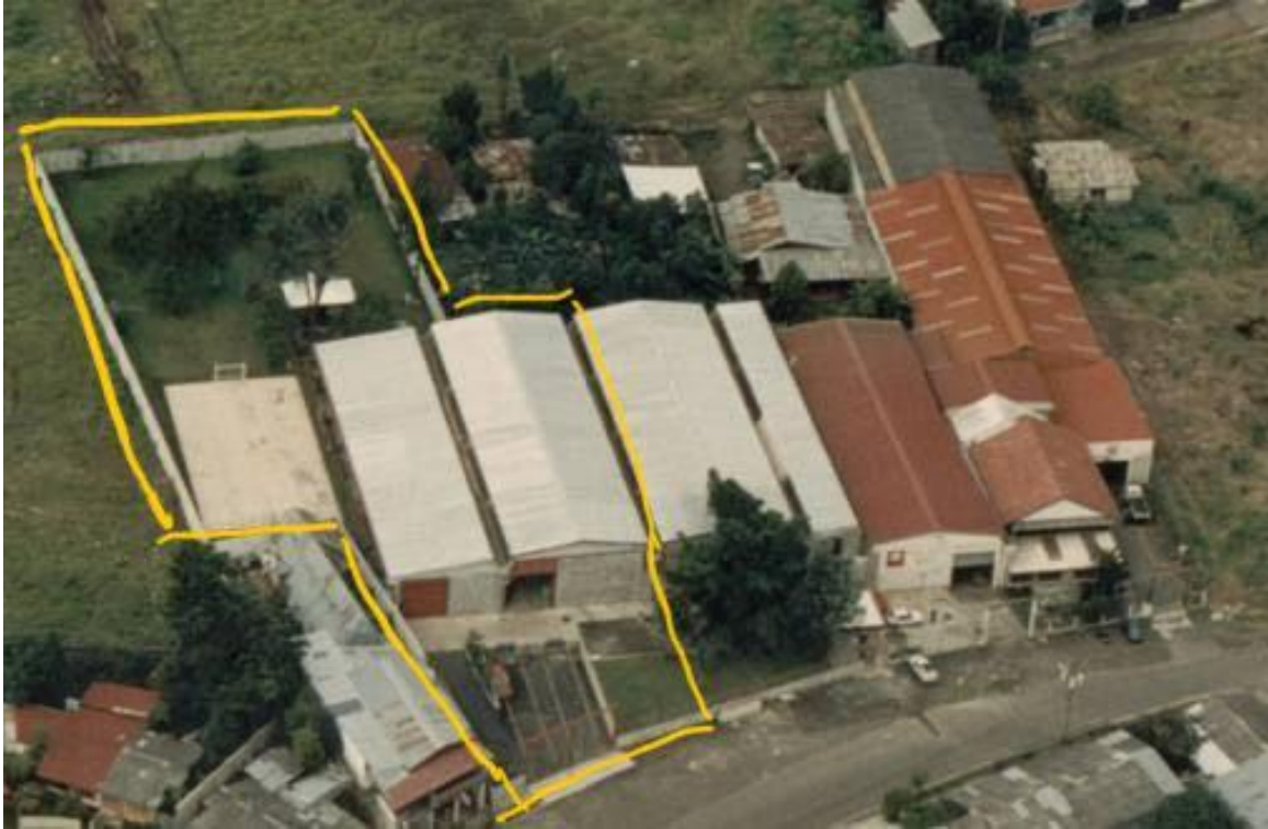
Figura 7. Imagen aérea de las instalaciones de la empresa
